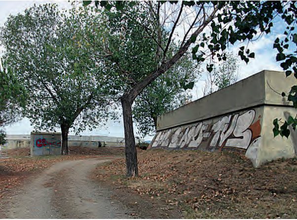
Figura 4. Dipòsits d'aigua en els Pinetons. El rectangular, de 1.000 m 3 , construït l'any 1970, i el circular, de 2.000 m 3 , construït l'any 1978. Foto: A. Collado
