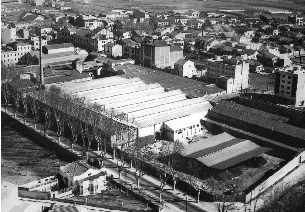
Figura 4. Al centre, fàbrica de Can Mulà. A l'extrem inferior esquerra, casa del director, Timoteu Parera
