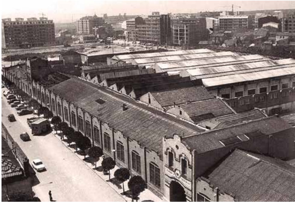
Figura 3. Edifici de la fàbrica entre el c/Burgos i l'av. Llibertat
