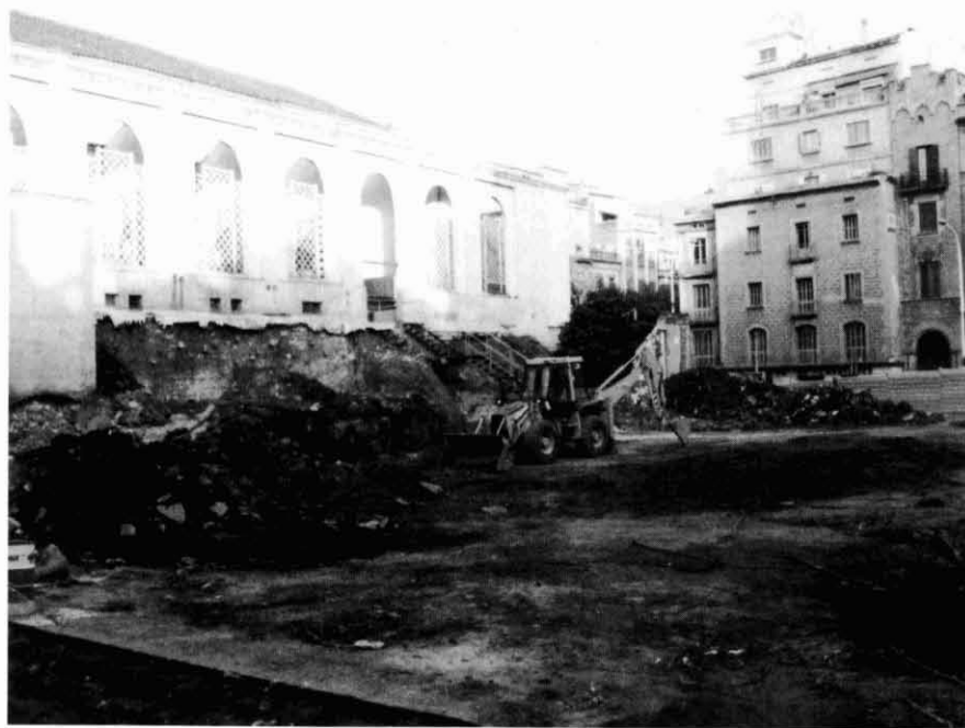
La plaça de Sant Domènec durant l'aixecament dels paviments pre-existents, amb la màquina retro-excavadora utilitzada, pas previ per la realització dels sondejos arqueològics. (Foto: Eduard Sánchez).
