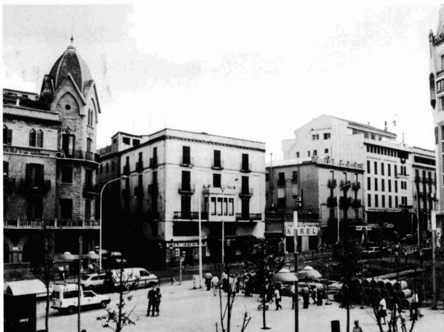
Detall de la plaça de Sant Domènec durant les obres de reforma de 1997, que afectaren l'espai on es documenta la muralla i el portal de Predicadors, al fons de la imatge. (Foto: David Olivares).
