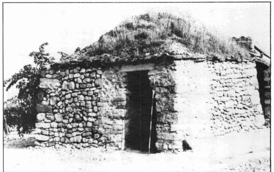
Vista general de la barraca tipus del terme d'Artés. (Foto Jordi Perramón).
