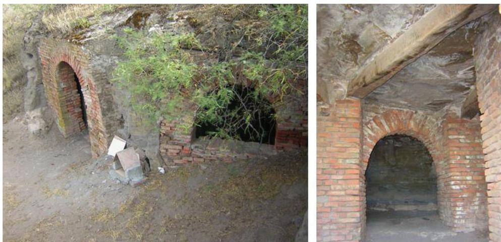
**Figura 5:** Cueva Maragata CM2, vista exterior y detalle del apuntalamiento de techos y paredes en sus cámaras internas (Fotografías de la autora).
