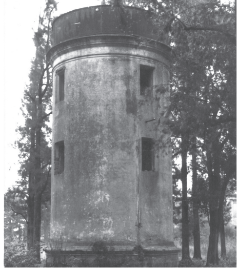
Figura 7: Tanque de agua. (Fotografía N° 87, Archivo DD.HH., Morón).
