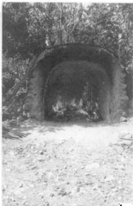
FIGURA 5a. — Vista del horno o kum'k'u de Luis Chi (Tepakán), a punto de terminar el proceso de cocción.
