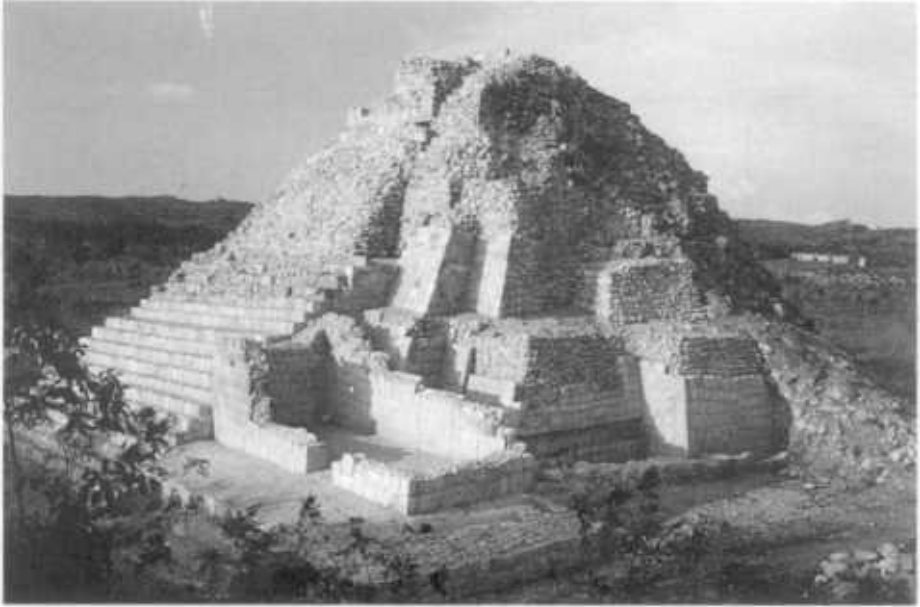
FIGURA 4.— La estructura CA-4.
