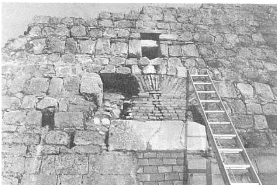
Fig. 5. Fachada NW de la Torre de Albolafia, Córdoba, con los dos fragmentos de un pedestal.
