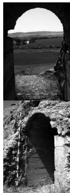
Figura 2.- Detalle del Fortín IV de La Boyeriza en San Martín de la Vega.
