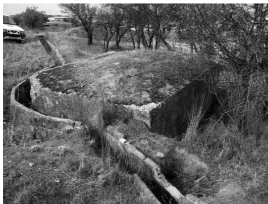
Figura 22.- Vista general del búnker 2 del PAU de “La Montaña”, en la que se aprecia la acequia construida después de la guerra.
