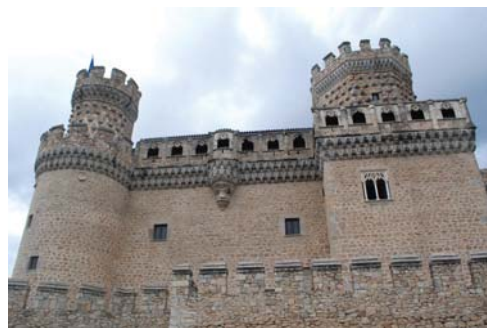
Fig. 13. Andamios del Casillo-Palacio de Manzanares, finales del siglo XV.
