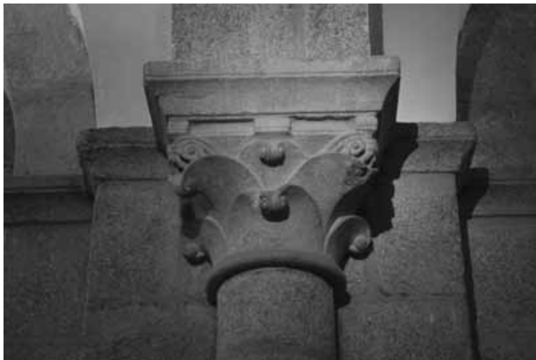
Fig. 17. Santiago de Compostela, catedral, capitel del muro oeste de la cripta.
