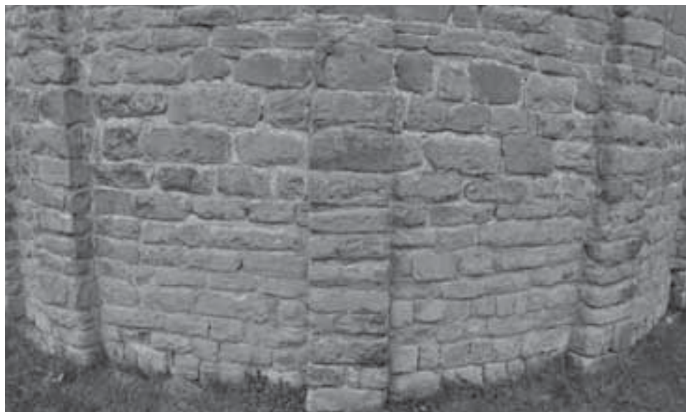
Fig. 6. Detalle del ábside de San Caprasio de Santa Cruz de la Serós
