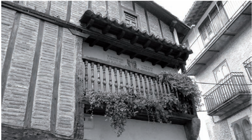
Fig. 1. Balcones y estructuras de madera en Candelario (Salamanca)
