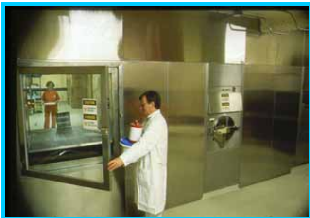
Foto 3: Puerta exterior del sas. (Foto cedida por Marisa Arias, directora técnica del CISA)
