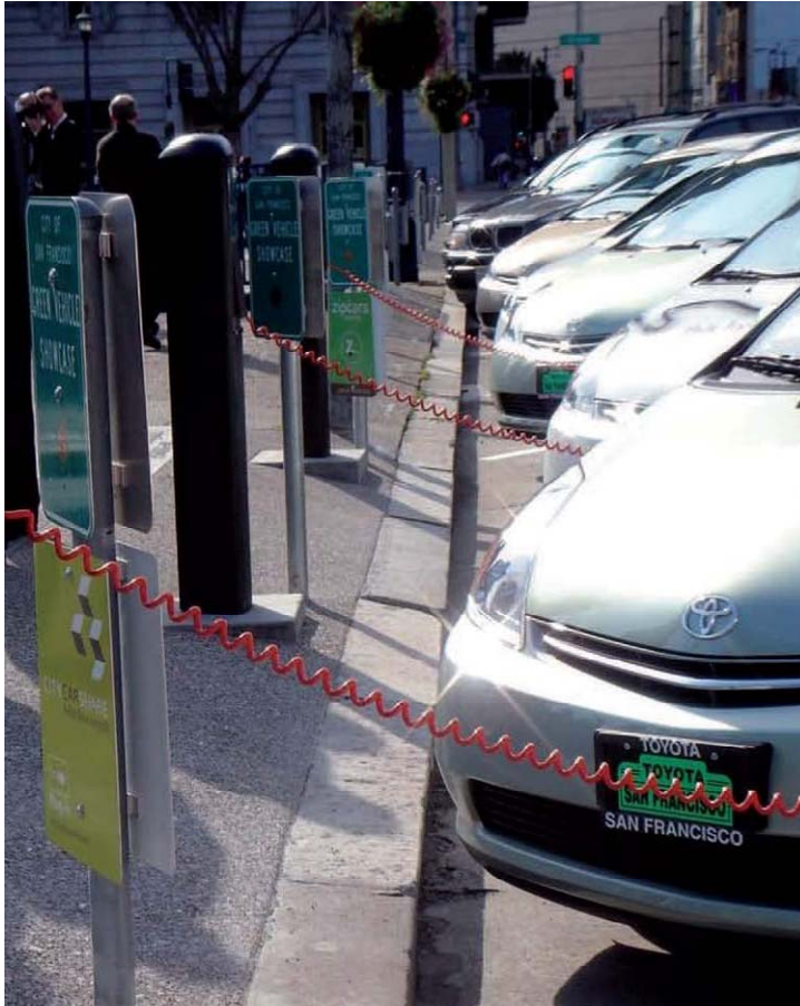
Figura 3. Puntos de recarga de vehículos eléctricos en San Francisco, EEUU.
