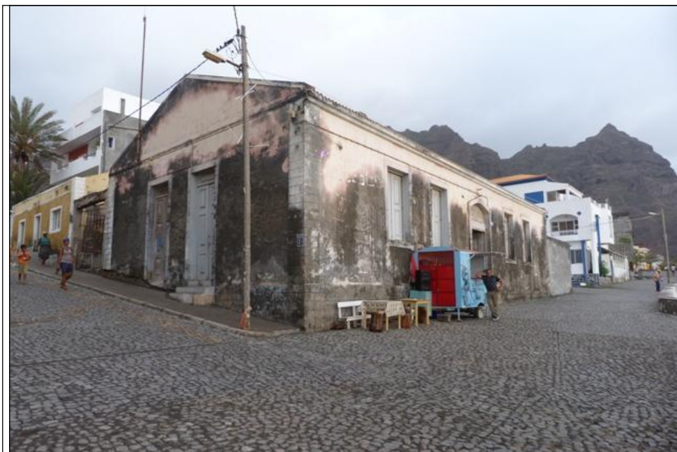
Ilustração 15: Ex. Armazém da Empa
