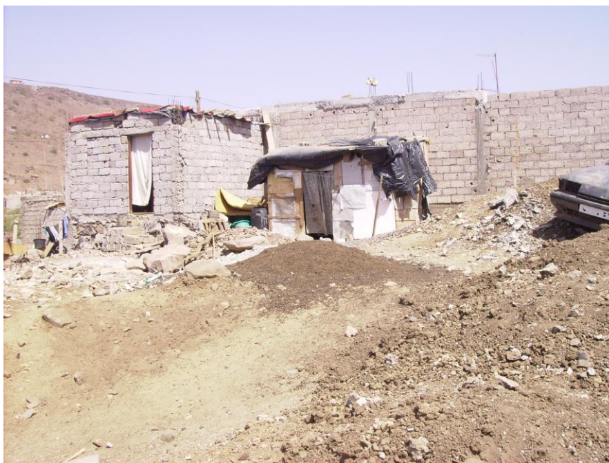
Photo 11 – Partie de maison et baraque à côté Photo de l’auteur
