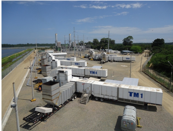
Figura 3. 2. Instalación de las turbinas TM-2500.
