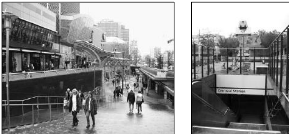
Εικόνα 3.20: (αριστερά) Ημιυπόγεια εμπορικά καταστήματα στο Rotterdam (δεξιά) Υπόγειος σταθμός μετρό στο Rotterdam (Πηγή: Stoter, 2004)
