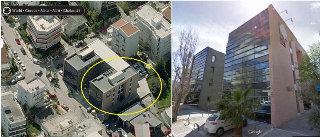
Εικόνα 8.8: Άποψη του υπό μελέτη κτηρίου με το Bird's Eye των Bing Maps (αριστερά) και τη χρήση του Google Street View των Google Maps (δεξιά)
