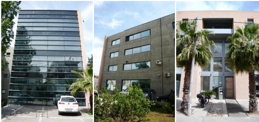
Εικόνα 8.9: Φωτογραφίες εδάφους του υπό μελέτη κτηρίου
