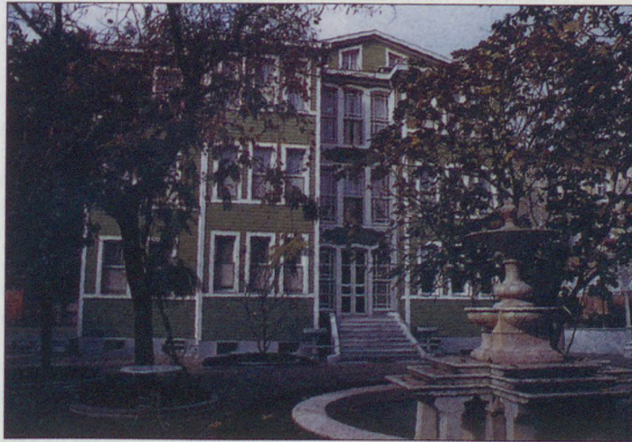
Restorasyon sonrası otel durumuna getirilen Yeşil Ev
