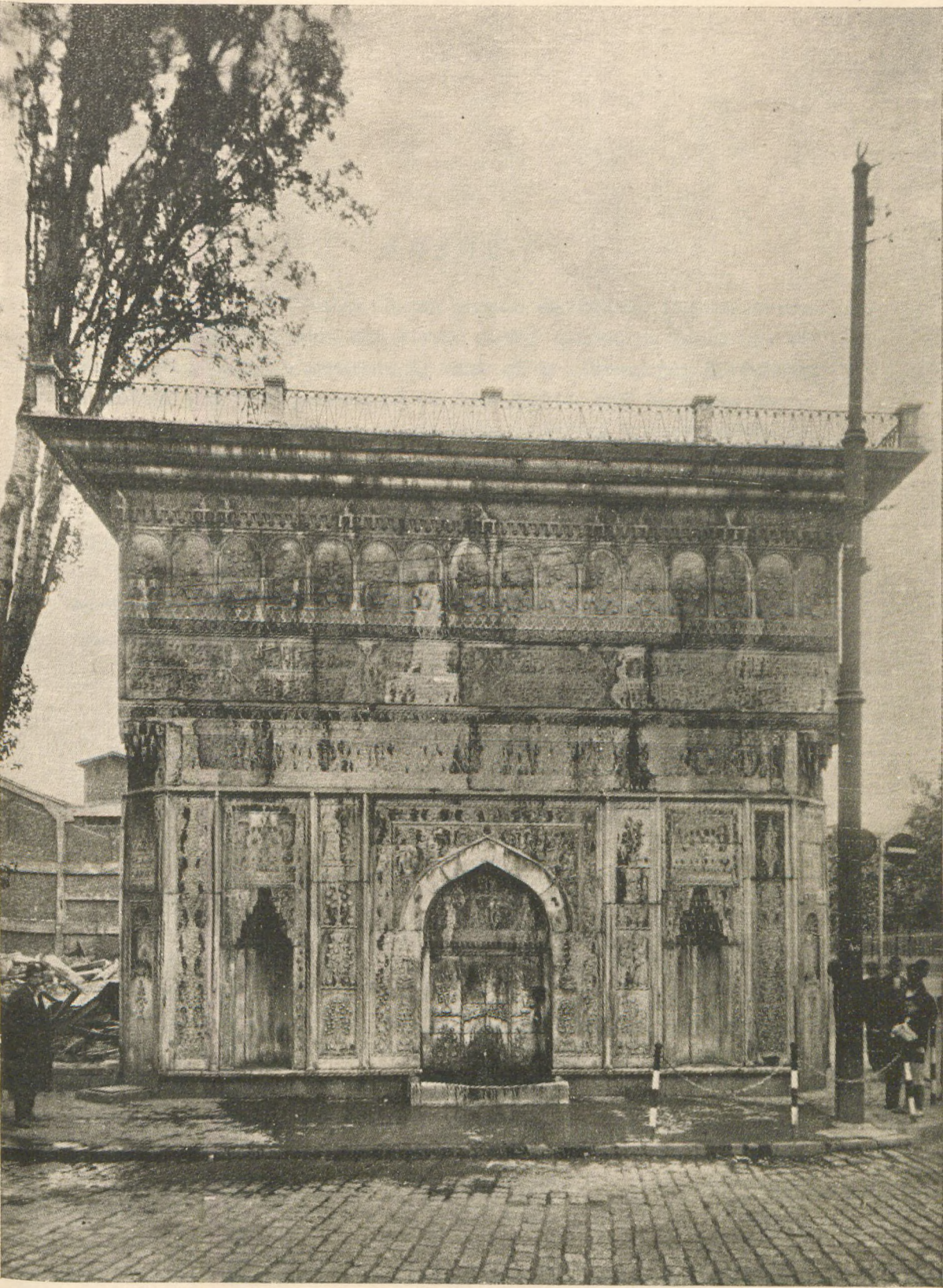
Tophane Çeşmesinin tamirden evvelki umumî görünüşü.
