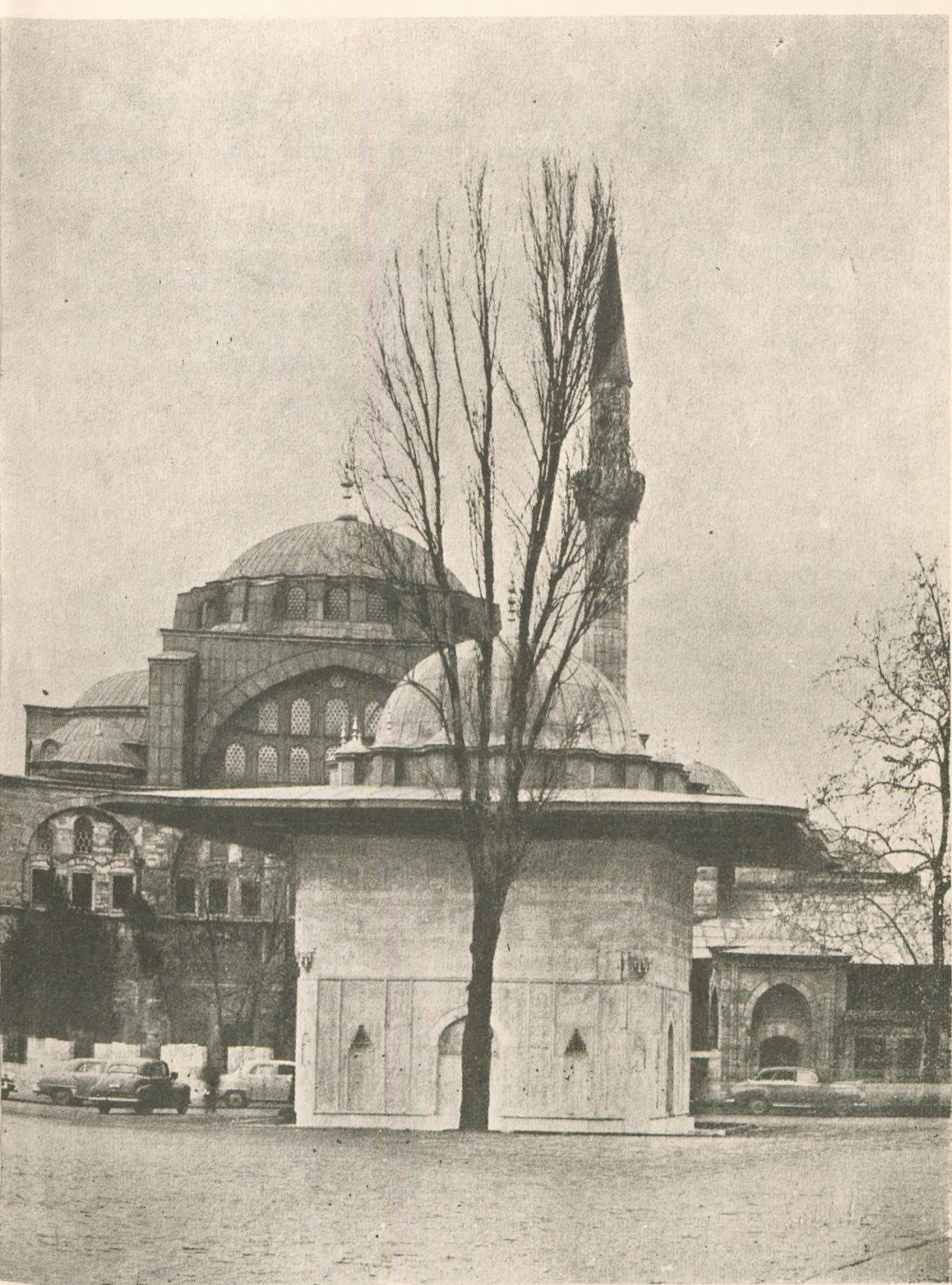
Tophane Çeşmesinin umumî görünüşü. ( Restorasyondan sonra )
