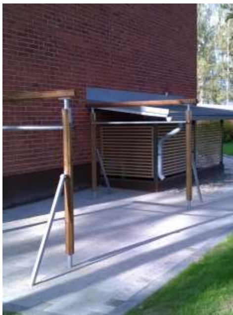
Kuva 24. Kuivausteline asennettuna kiveyksen alle
