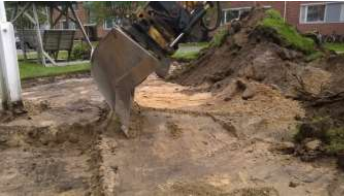
Kuva 9. Kaivumaan väliaikainen läjittäminen
