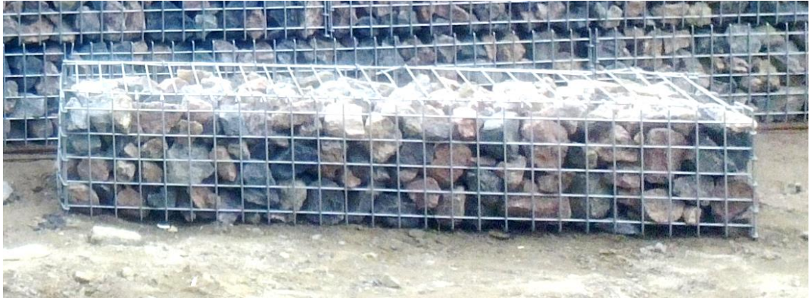
Kuva 1. Koneellisesti ladottu kivikori. [1]
