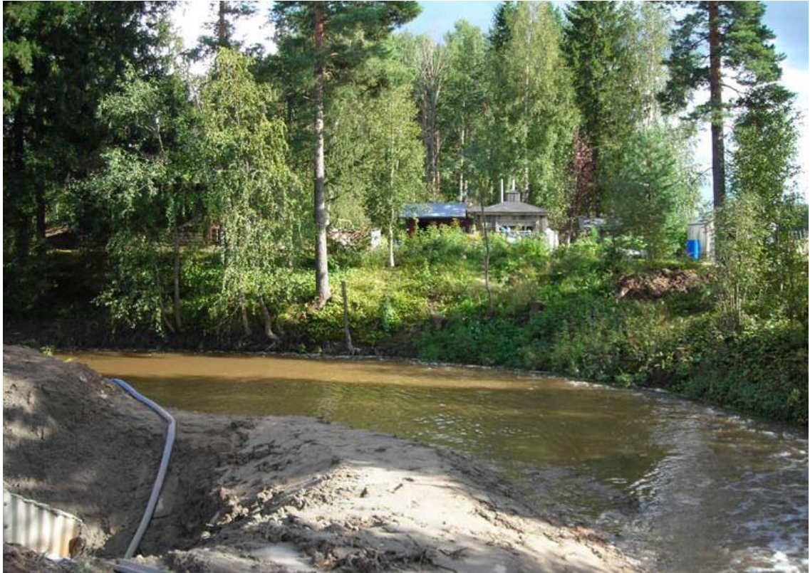
Kuva 7. Työpato ja sen kuivana pito. [1]
