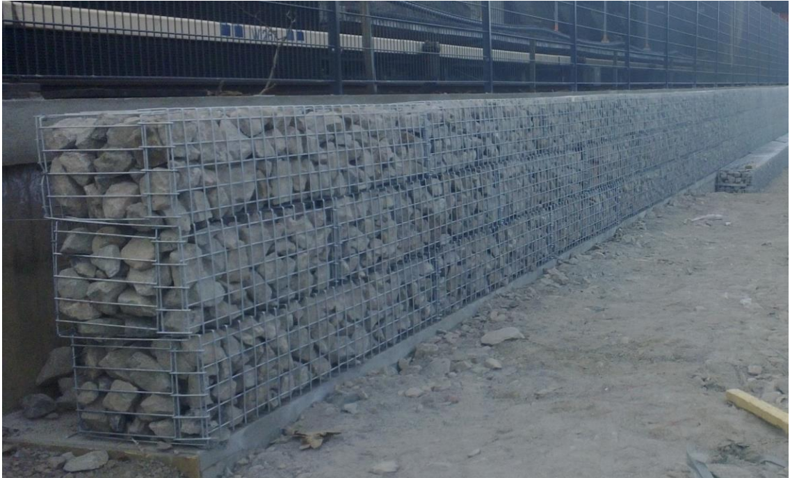
Kuva 21. Valmiskivikori muuri. [1]
