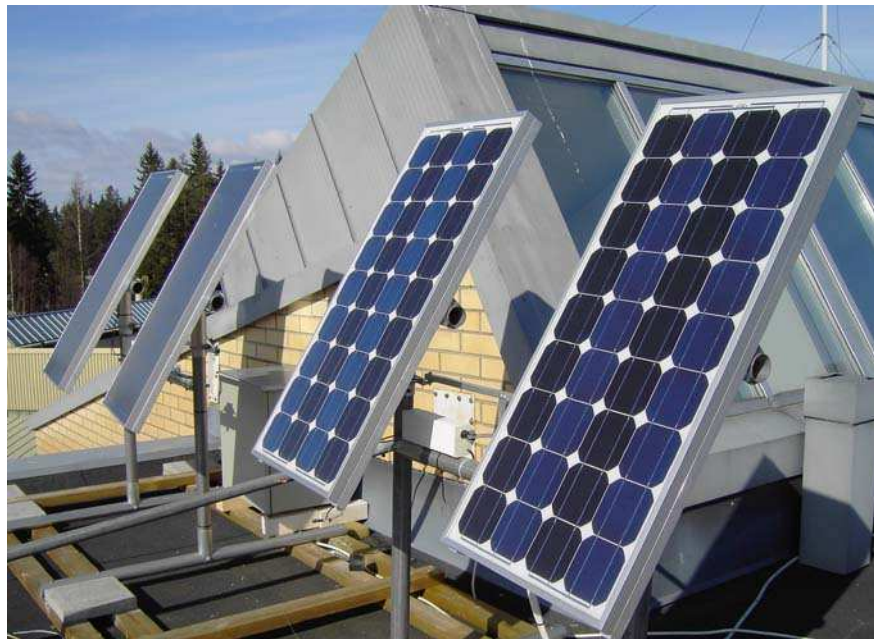
Kuva 32. Aurinkopaneelien asennusteline.
