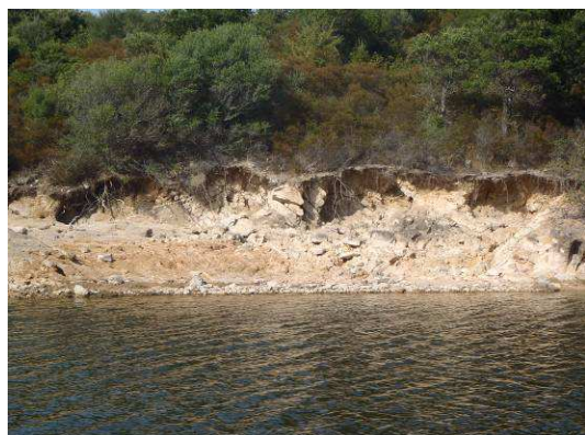
Lago Liscia, erosione spondale
