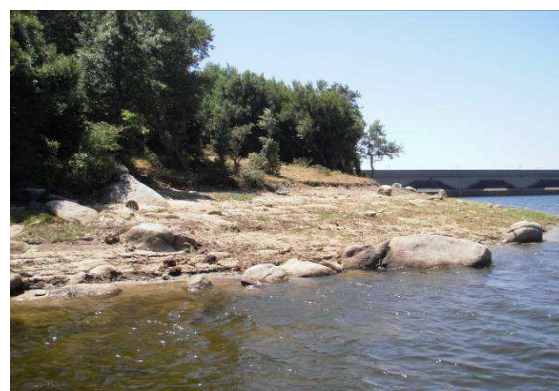
Lago Sos Canales, sponda e diga
