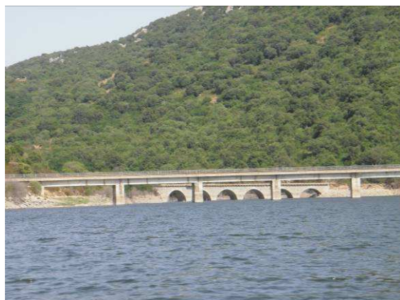
Lago Liscia, attraversamento
