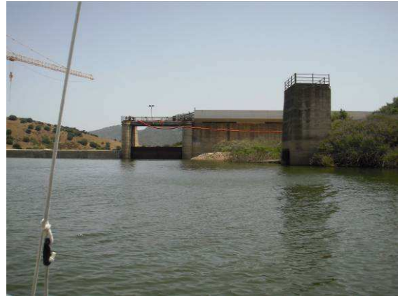
Lago Posada, diga e particolare paratoia
