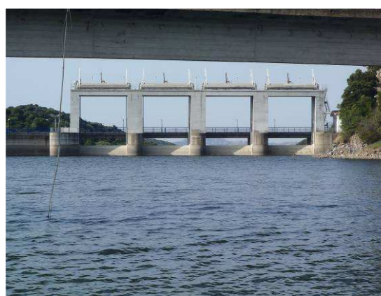
Lago Liscia, particolare: paratoie diga
