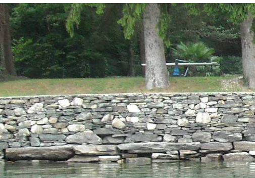
Opere di ingegneria classica, aperte, sulla sponda (foto M. Ciampitiello)
