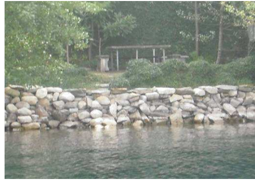
Opere di ingegneria naturalistica sulla sponda (foto M. Ciampitiello)
