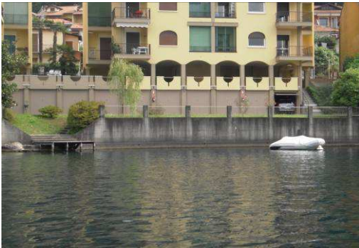
Opere di ingegneria classica, chiuse, sulla sponda (foto M. Ciampitiello)
