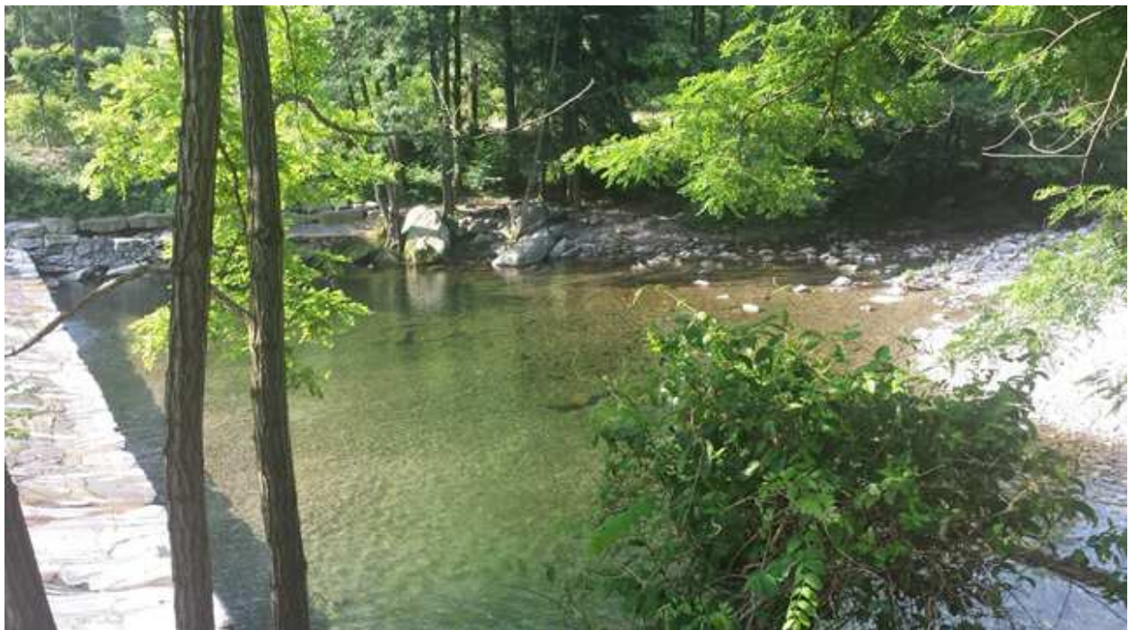
Figura 7. Sito di "Ramello". Vista del bacino formatosi a valle della traversa.
