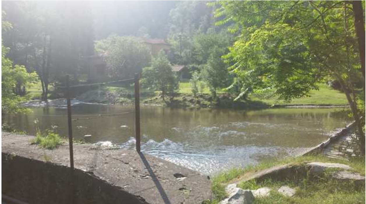
Figura 6. Sito di "Ramello". Vista del bacino formatosi a monte della traversa. Immagine scattata dalla presa di alimentazione del canale di derivazione.
