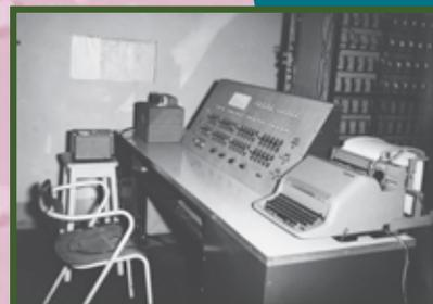
Il Quadro di Controllo Manuale della Macchina Ridotta, a destra è posizionata la telescrivente Olivetti T2CN, a sinistra, sul tavolo il lettore Ferranti TR Mk2 e sul panchetto il lettore Olivetti T2TA10. [Archivio Università di Pisa]
