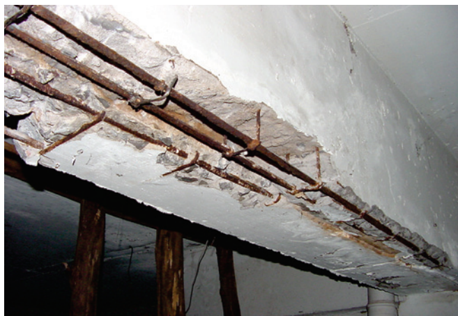
Figura 2 - Vigas de concreto armado com banzo tracionado danificado por corrosão (Ferrari (5))
