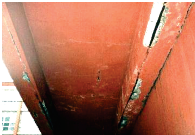
Figura 2 - Vigas de concreto armado com banzo tracionado danificado por corrosão (Ferrari (5))
