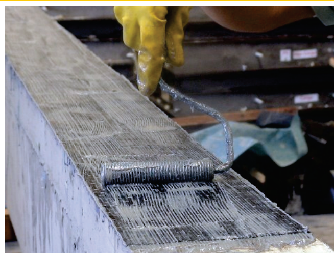
Figura 8 - Aspecto do substrato tracionado após a remoldagem e após a colagem do reforço externo
