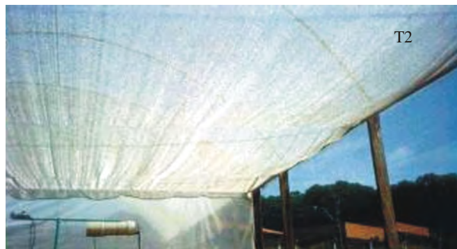
Figura 1. Vista interna da disposição das malhas de sombreamento no ambiente 1 (T1) – termorrefletora externa (A); ambiente 2 (T2) – termorrefletora interna (dentro do ambiente protegido) (B)
