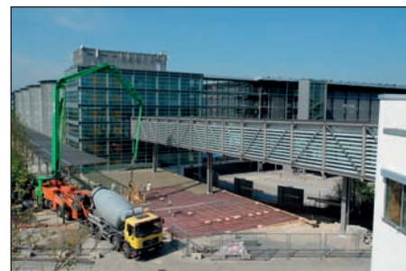
Aktuelle Baumaßnahmen am neuen Eingang Nord-West des Messegeländes München Foto: bauma
