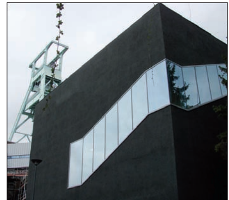
Fassadenansicht mit Förderturm
