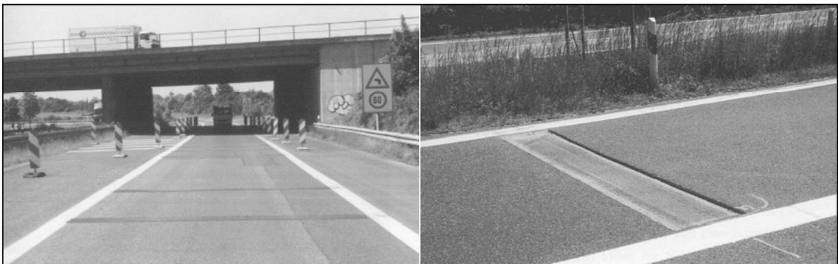
**Bild 6:** Rüttelstrecke in Verbindungsrampe (links) und Ausführungsdetail gefräster Rüttelstreifen (rechts) (BRILON/BÄUMER/WEISE, 2001)
