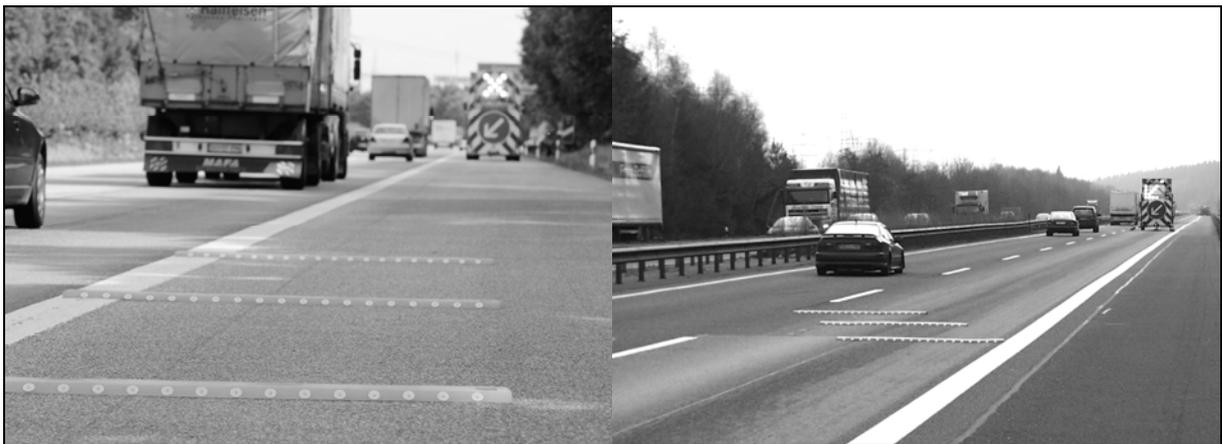
**Bild 8:** Einsatz von Warnschwellen bei einer Arbeitsstelle kürzerer Dauer auf dem Seitenstreifen (links) (STRASSENNRW, 2005) und auf dem rechten Fahrstreifen (rechts) (STEINAUER et al., 2004)
