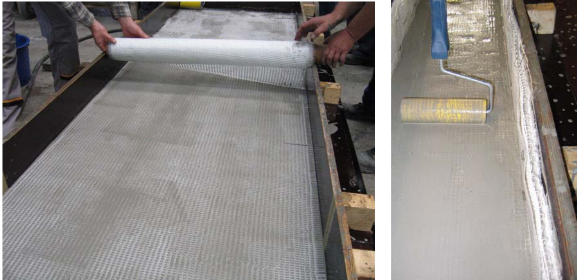
Bild 9-7: Herstellung eines Hohlkastens: Einlegen zweidimensionaler Glaslege als Biegewehrung (links), Stegbewehrung aus dreidimensionalen Abstandsgewirken mit aufgeklebten Abstandhaltern aus Beton (rechts)
