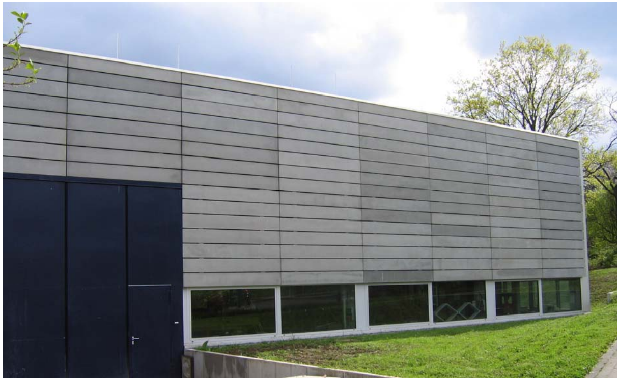
Bild 9-1: Textilbeton-Fassade des Erweiterungsbaus der Versuchshalle des IMB, RWTH Aachen
