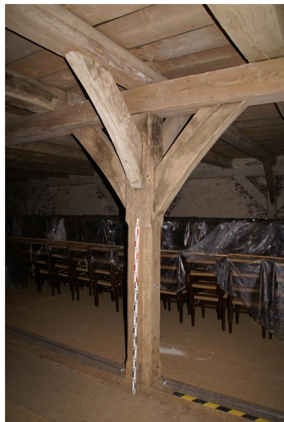
Abb. 119: Erstes Obergeschoss, Holzständer auf Schwellholz (Foto: A. Priesters, 11/2010)
