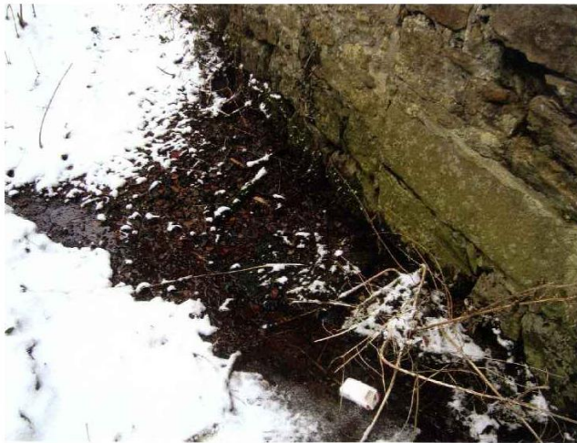
Abb. 88: Aussickerndes Wasser aus dem "Elefanten" bei Frost (Foto: E. Grigorieva, S. Resnikow, 11/2010)
