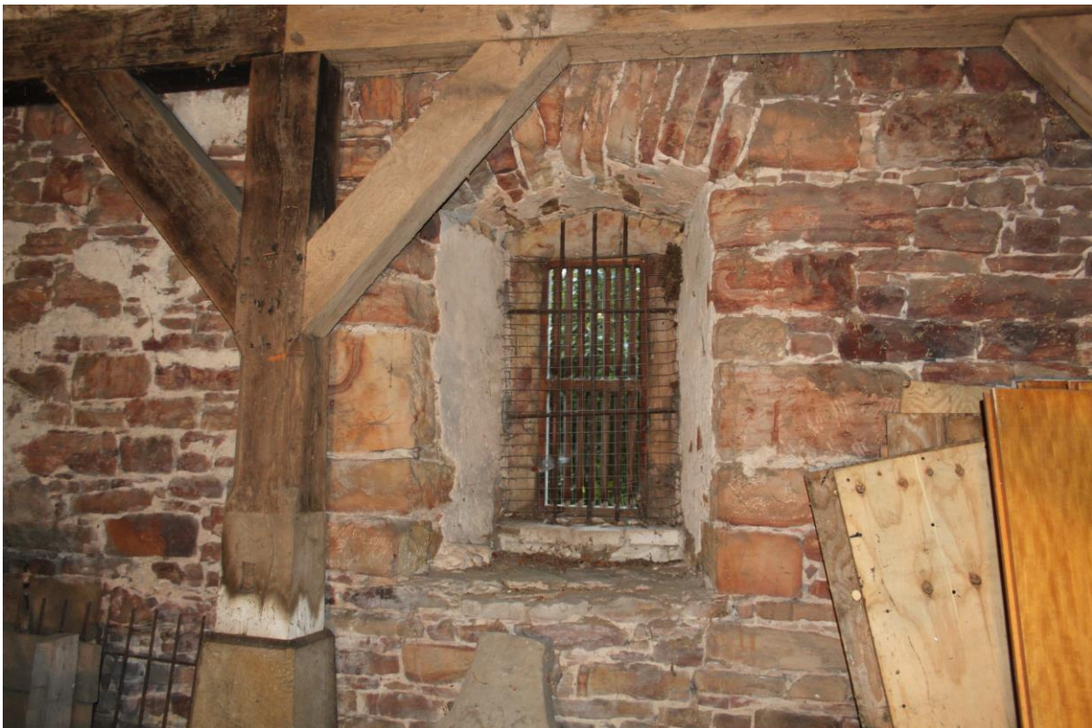
Abb. 114: Innenraum, Nordseite, Fenster 0.N11 (Foto: J. Eberhard, 11/2012)
