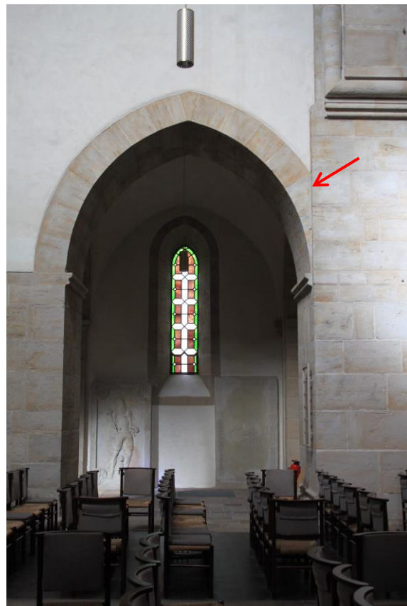
Abb. 51: Mittelschiff, Blick Richtung Norden, verdeckte Verschneidung von Arkadenbogen und Pfeiler Pn3 (Foto: J. Eberhard, 08/2018)
