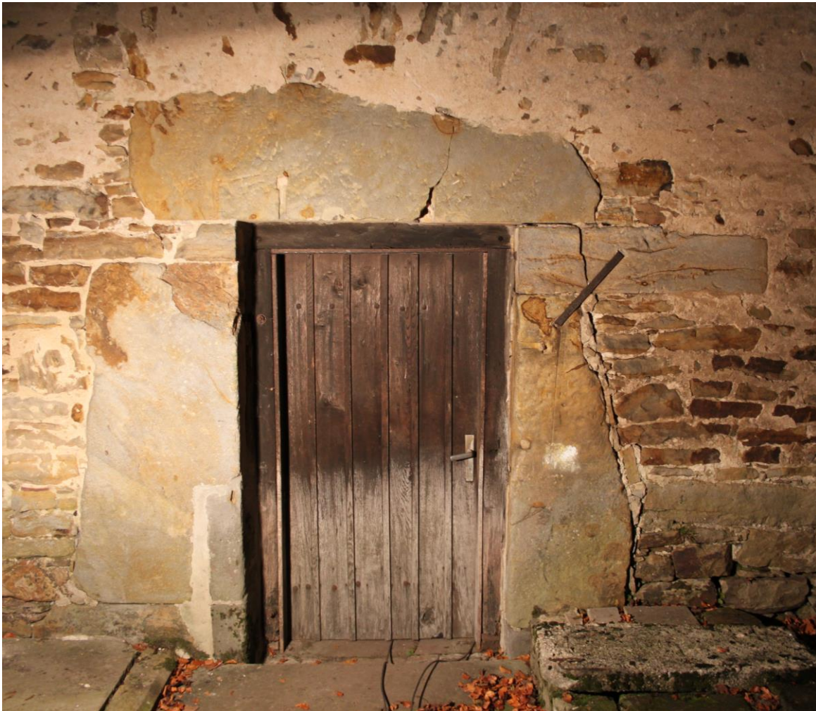
Abb. 109: Südfassade, Tür 0.S6 (Foto: J. Eberhard, 11/2011)
