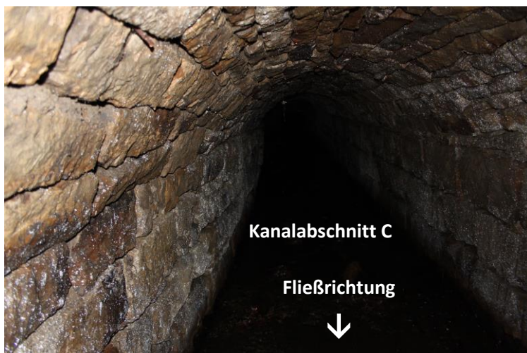
Abb. 19: Kanalabschnitt C, Blick Richtung Osten, Kanalhöhe ca. 2 m (Foto: J. Eberhard, 01/2014)
