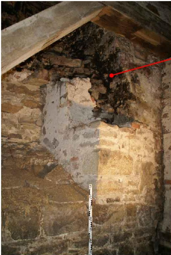
Abb. 123: Erdgeschoss, ehemaliger westlicher Kamin in der Südwand (Foto: A. Priesters, 11/2011)
