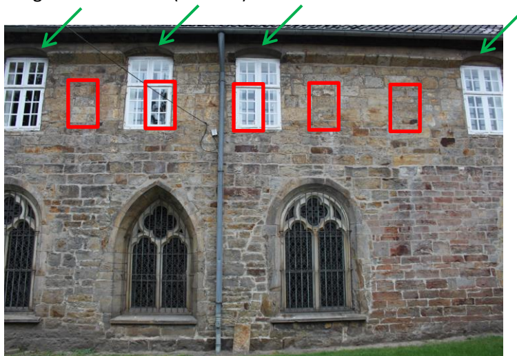
Abb. 64: Östlicher Klausurflügel, vermauerte Fenster im Mönchsdomitorium (rot), nachträglicher Segmentbogensturz (grün), (Foto: J. Eberhard, 09/2013)
