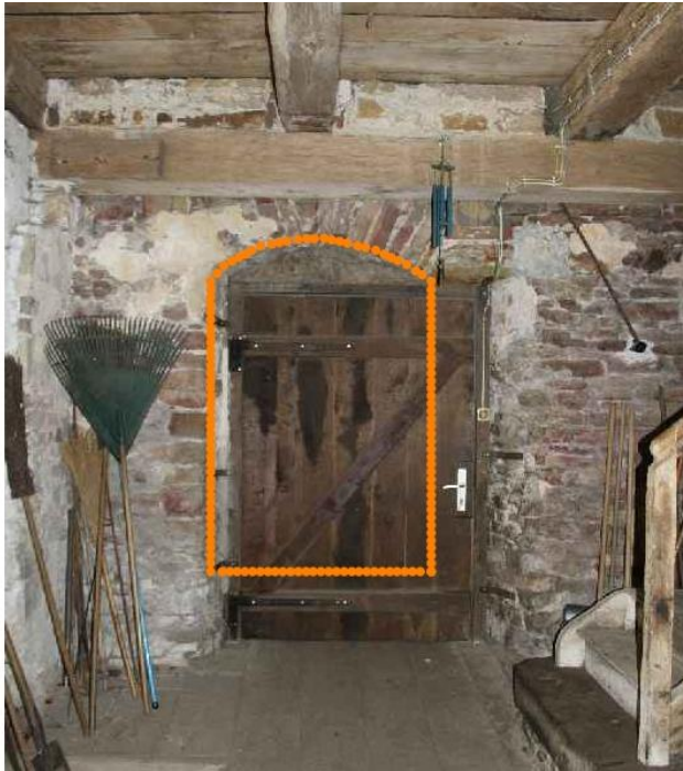
Abb. 108: Tür 0.S1, ursprünglich Fenster (orange), Blick Richtung Süden (Foto: J. Eberhard, 11/2011)
