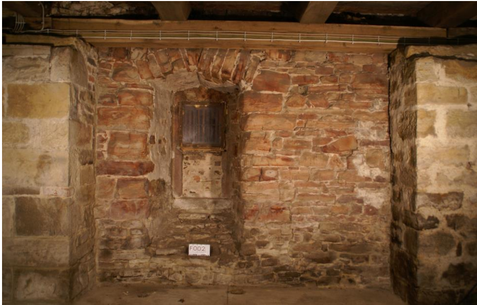
Abb. 107: Nordfassade, Fenster 0.N2, rot-violett gefärbtes Mauerwerk (Foto: A. Priesters, 03/2011)
