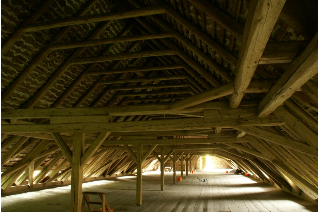
Abb. 121: Dachkonstruktion, Blick Richtung Westen (Foto: A. Priesters, 07/2011)
