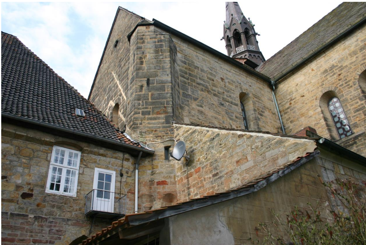
Abb. 65: Kirche von Südosten, Dachspuren an der südlichen Querschiffwand (Foto: J. Eberhard, 10/2014)
