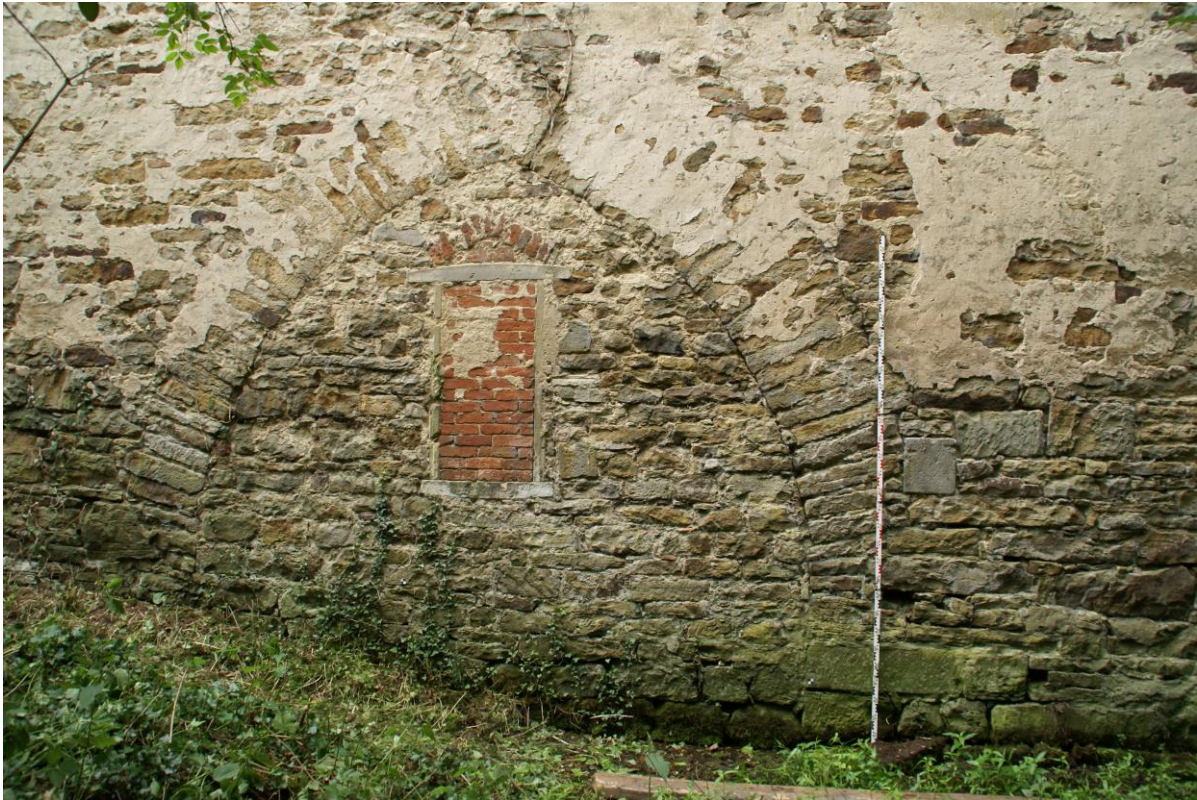
Abb. 96: Südfassade, vermauertes spitzbogiges Tor -1.S4 (Foto: A. Priesters, 08/2012)
