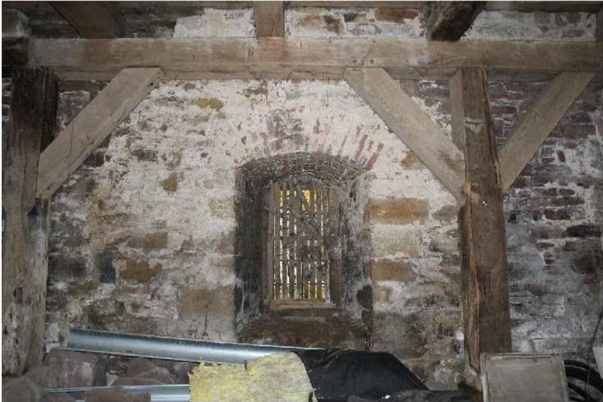
Abb. 125: Erdgeschoss, Südwand, später eingebautes Fenster 0.S8 anstelle des östlichen Kamins (Foto: J. Eberhard, 12/2011)
