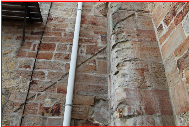
Abb. 66: Dachspur an der Ostwand der Johanneskapelle, (Foto: J. Eberhard, 10/2014)
