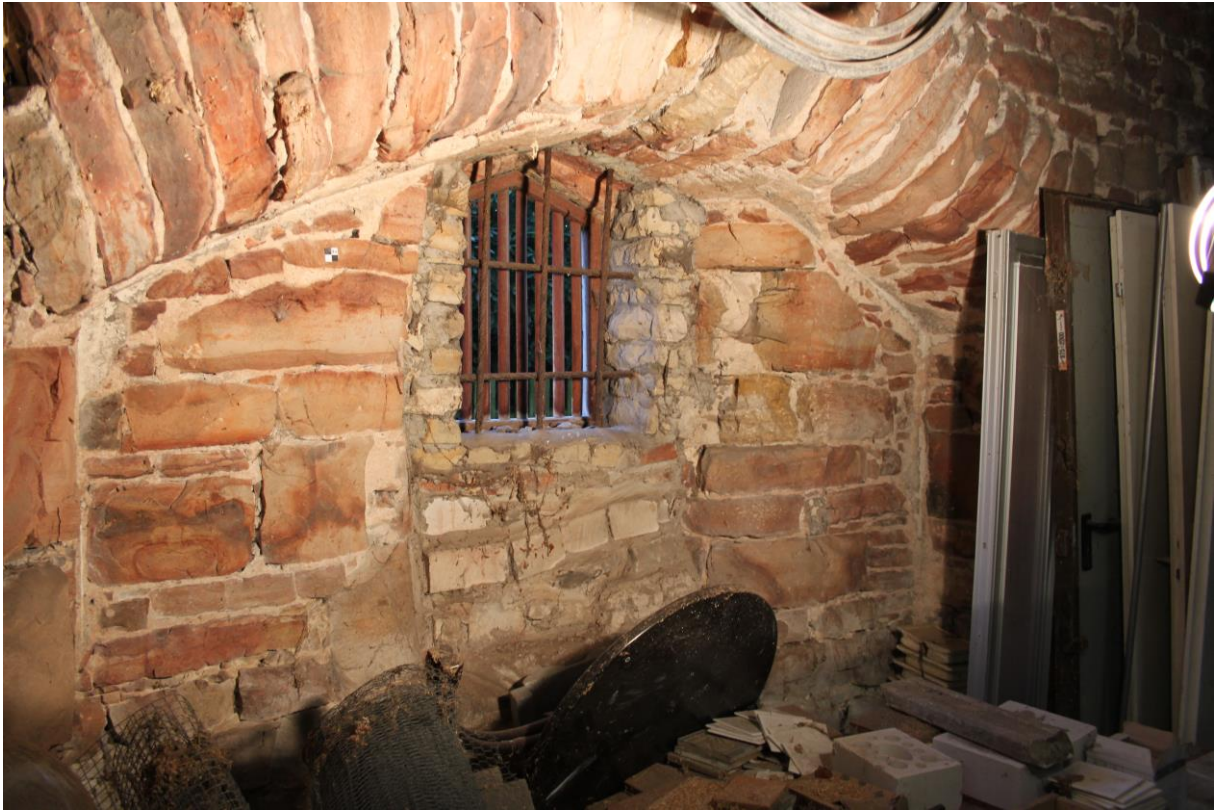
Abb. 126: Erdgeschoss, Nordseite, Wandnische 0.N7 (Foto: J. Eberhard, 12/2011)
