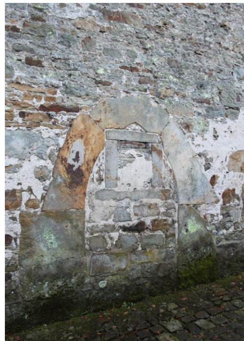
Abb. 99: Nordfassade, vermauerte Spitzbogentür 0.N5 (Foto: J. Eberhard, 09/2013)
