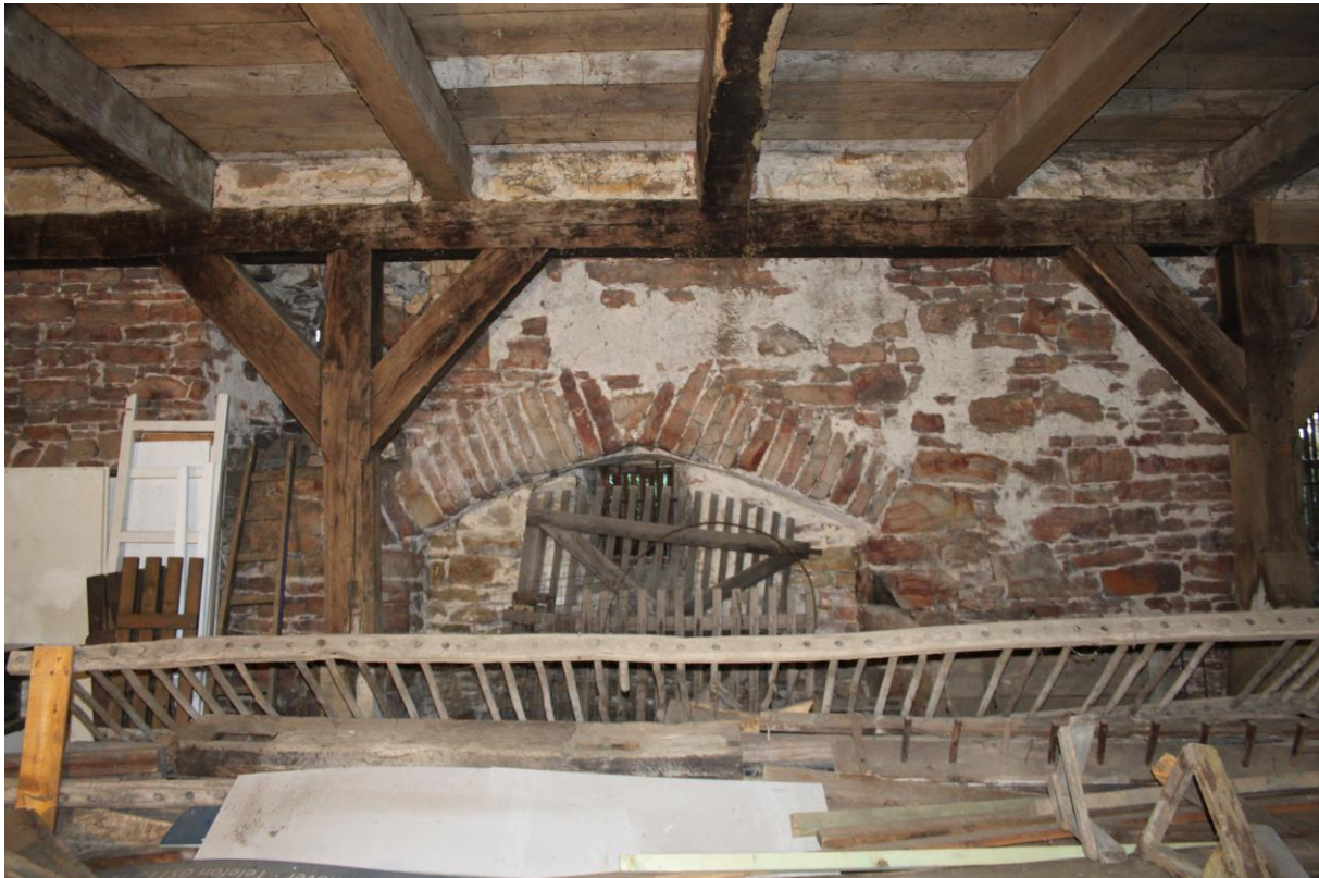
Abb. 118: Innenraum, Nordseite, wiederverwendete Eichenhölzer im Erdgeschoss (Foto: J. Eberhard, 11/2011)
