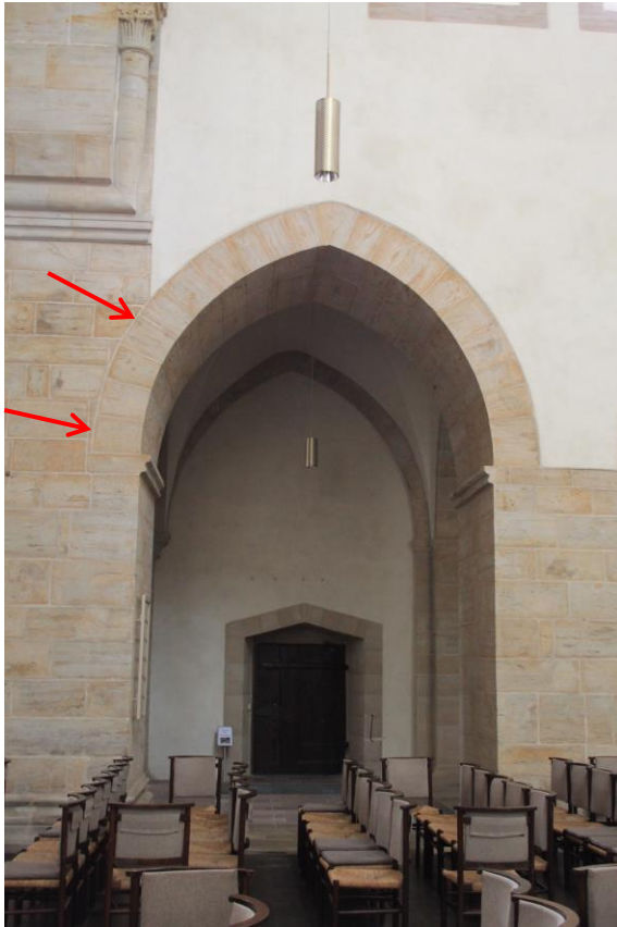
Abb. 50: Mittelschiff, Blick Richtung Süden, sichtbare Verschneidung von Arkadenbogen und Pfeiler Ps3 (Foto: J. Eberhard, 08/2018)
