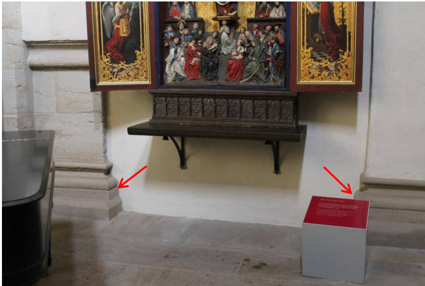
Abb. 47: Ehemaliger Kapelleneingang K1, Fußprofil (rote Pfeile) läuft in Wand ein (Foto: J. Eberhard, 09/2019)
