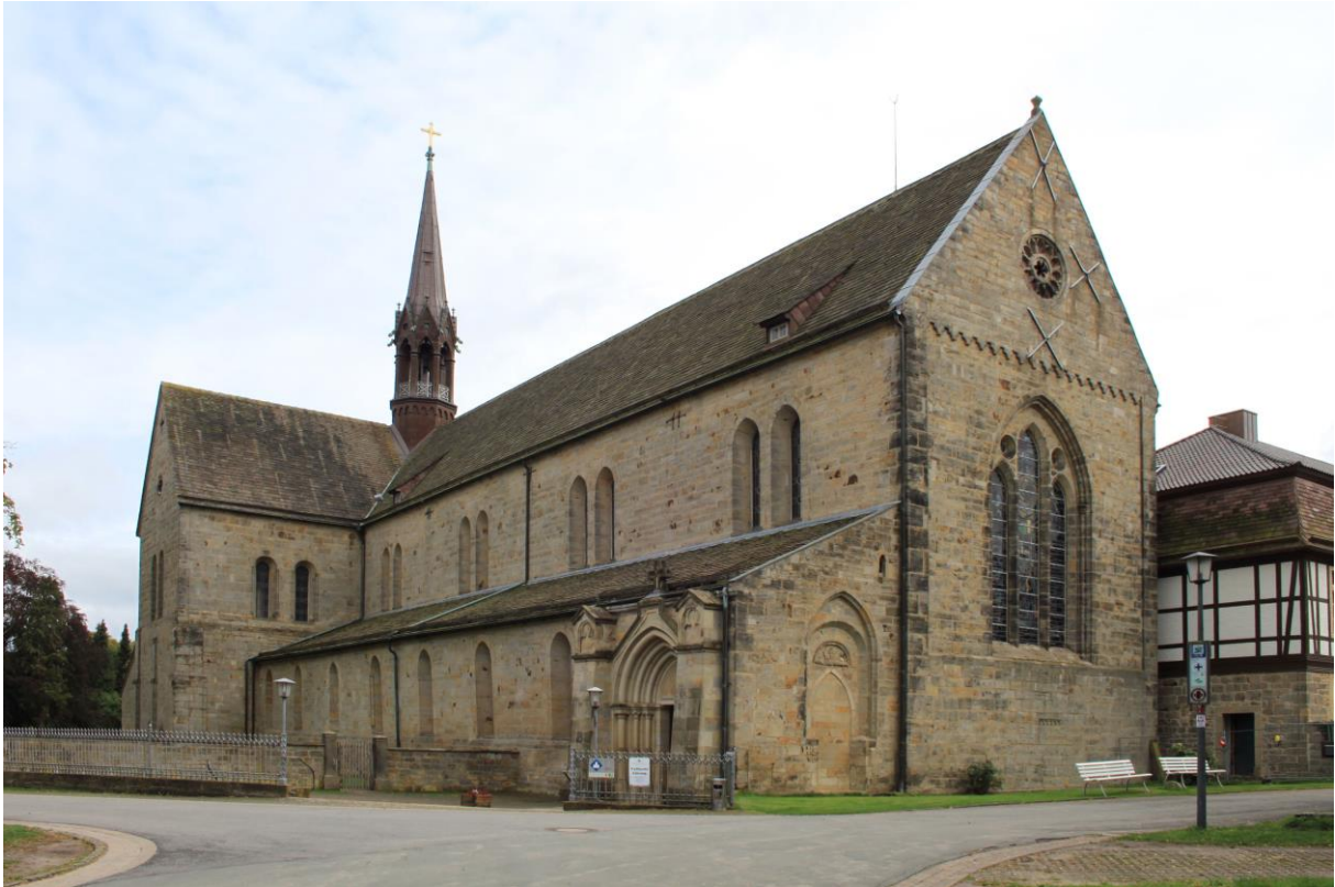
Abb. 21: Nordwestansicht der Klosterkirche (Foto: J. Eberhard, 07/2018)
