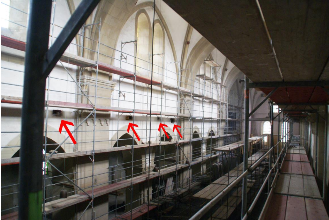
Abb. 2: Nördliche Hochschiffwand während der Sanierung im Mai 2011 (Foto: A. Priesters, 05/2011)
