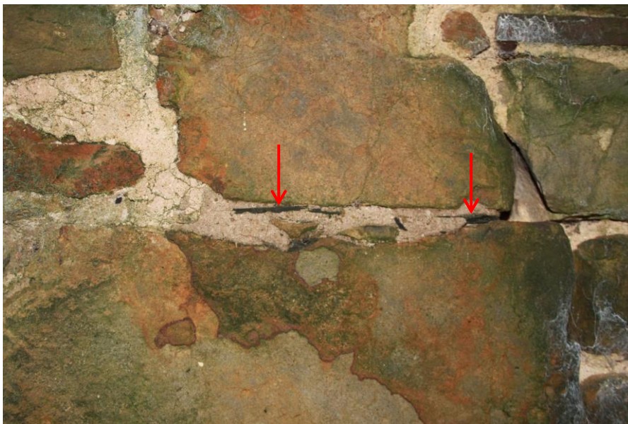
Abb. 84: Südfassade, Fenster -1.S2, dünne Schieferplättchen (rote Pfeile) in den Fugen (Foto: J. Eberhard, 02/2013)
