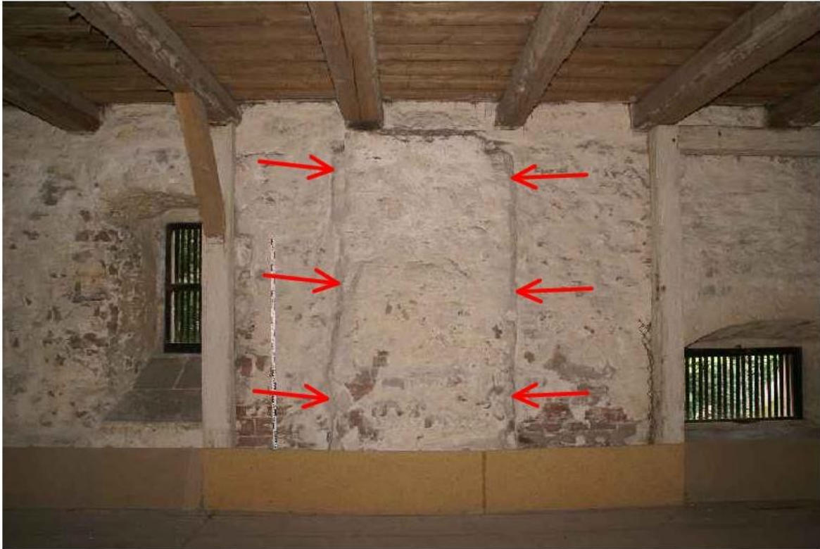
Abb. 124: Zweites Obergeschoss, hervorgewölbtes Mauerwerk am ehemaligen östlichen Kaminschlott, (Foto: A. Priesters, 05/2011)
