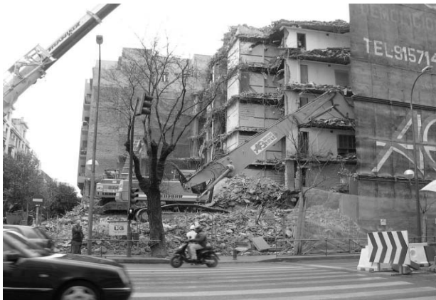
Figura 24.- Demolición sin aprovechamiento racional.
