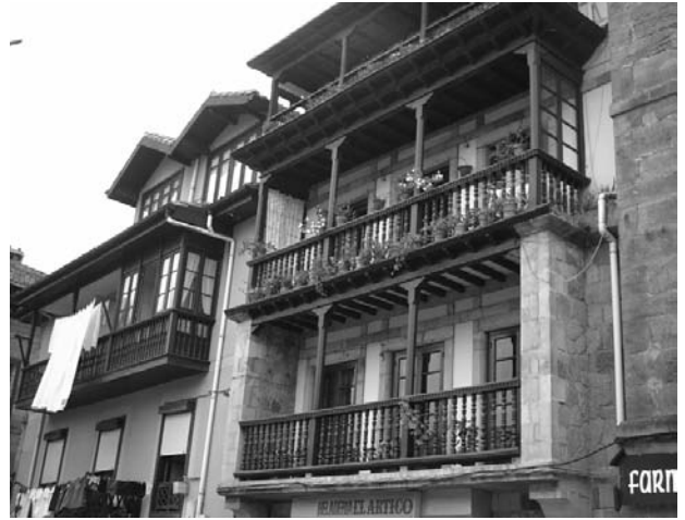
Figura 3.- Pilares y vigas de madera.
