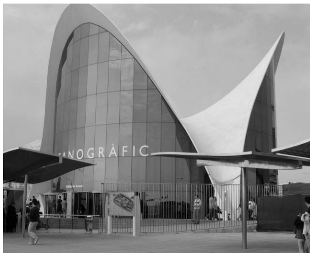
Figura 19.- Importancia de la cubierta en la silueta del edificio.
