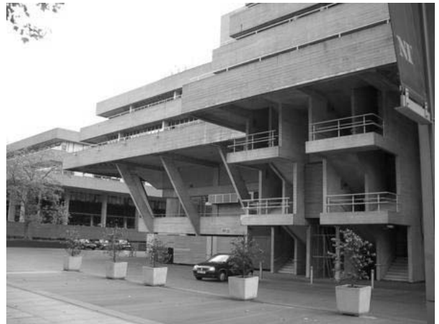
Figura 4.- Estructuras de hormigón; pilares, vigas y muros.
