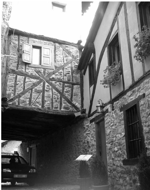
Figura 2.- Sistema murario de entramado.
