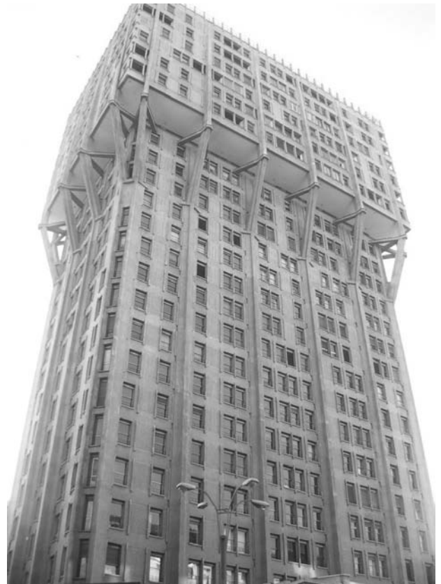
Figura 14.- Estructuras de pilares y vigas que influyen en la imagen del edificio.
