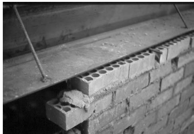
Figura 7.- Estructura auxiliar realizada «in situ» para apoyo de hoja exterior.
