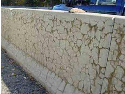
Figura 2.13 Reazione alcali-aggregato
