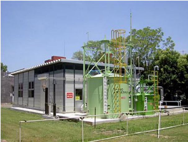
Figura 5.10 (a) Veduta dell'impianto.
