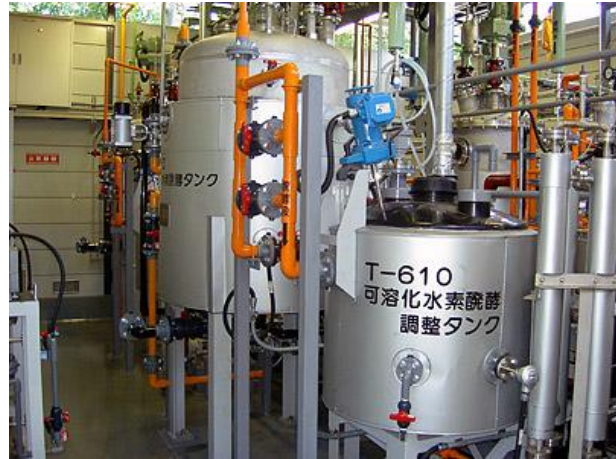
Figura 5.10 (b) I due serbatoi di fermentatore e digestore.
