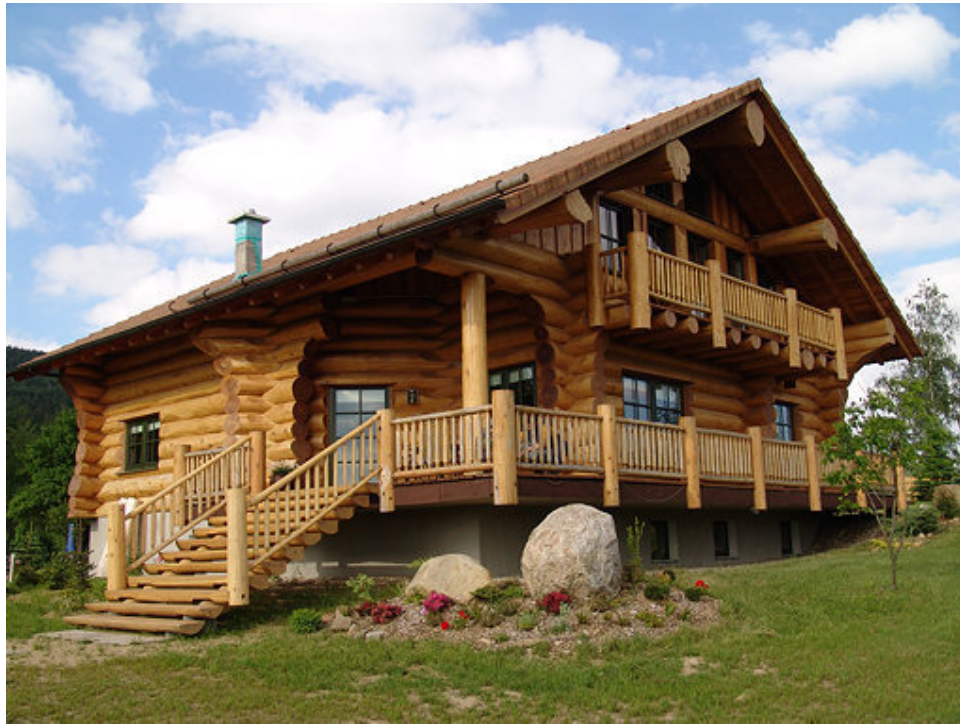
Fig.1.8 Esempio di una casa tipo “block bau”, tipica delle zone alpine italiane.[68]
