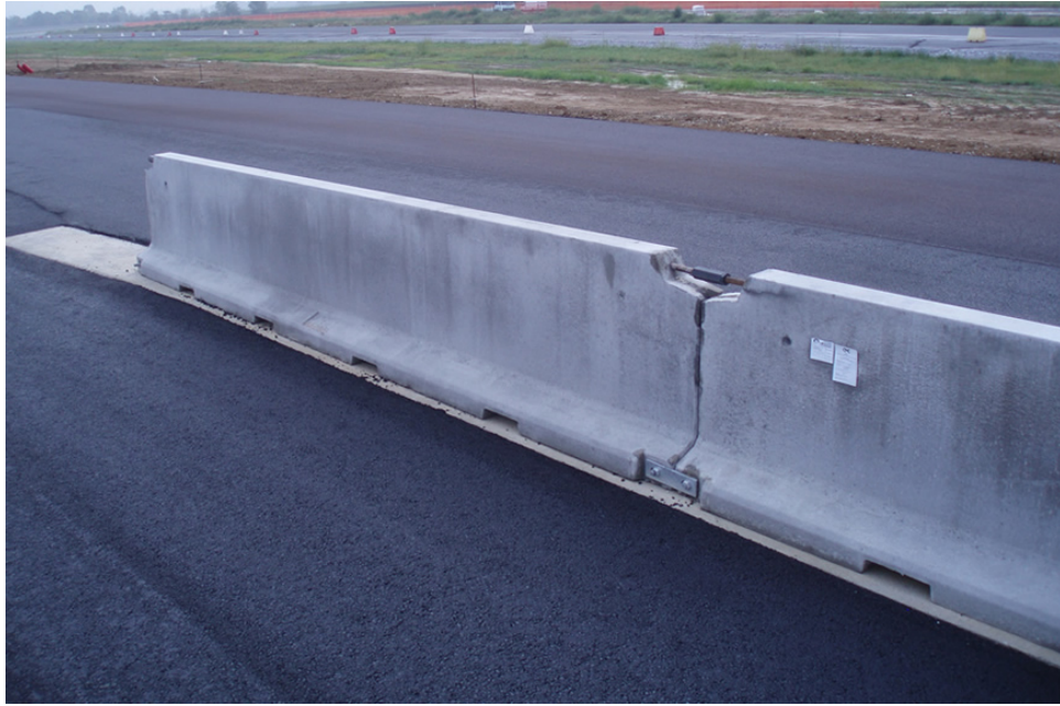
Fig.1.1 Barriera in calcestruzzo tipo "New Jersey" [70]
