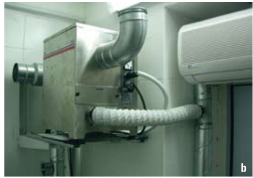
Figura 5.20. Equipamiento para la deshidratación del BG-SAR: medidor con los valores ambientales de humedad relativa y temperatura (a), deshumidificador químico (b) y material almacenado (c).
