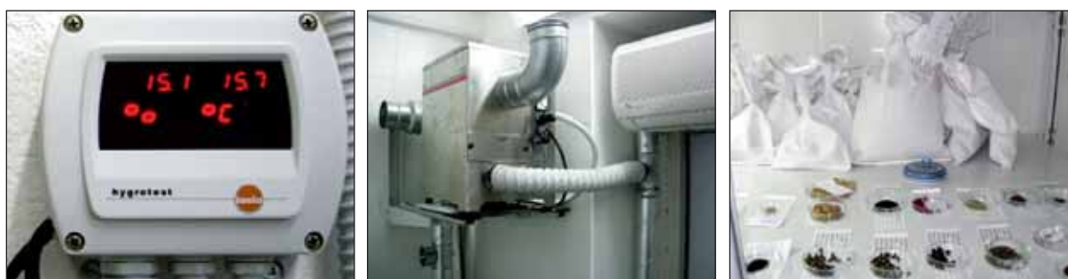
Figura 22 - Strutture per la deidratazione presso BG-SAR: umidostato con valori ambientali di umidità relativa e temperatura, deumidificatore ad assorbimento chimico e materiale stoccato. (foto: E. Mattana)
