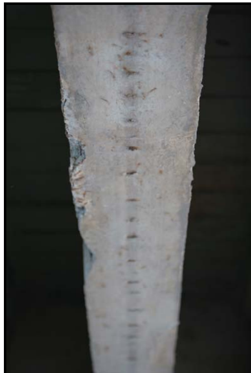
Foto 6.14, Foto 6.15: Manifestazioni di degrado presenti nell'estremità dx, in mezzeria e nell'estremità sx di E 4
