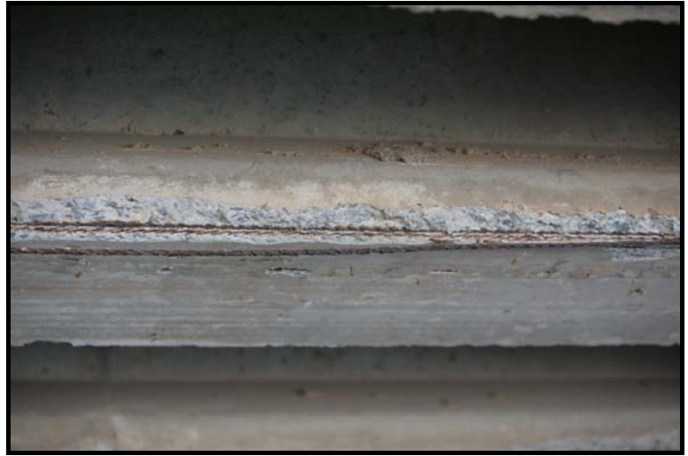
Foto 6.25, Foto 6.26: Manifestazioni di degrado presenti in mezzeria, nell'estremità sx dell'elemento E 9
