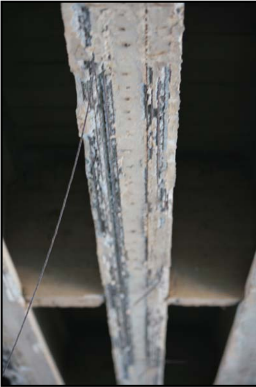
Foto 6.25, Foto 6.26: Manifestazioni di degrado presenti in mezzeria, nell'estremità sx dell'elemento E 9
