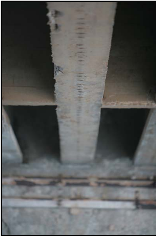
Foto 6.14, Foto 6.15: Manifestazioni di degrado presenti nell'estremità dx, in mezzeria e nell'estremità sx di E 4
