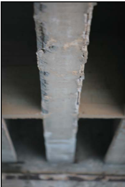
Foto 6.16, Foto 6.17: Manifestazioni di degrado presenti nell'estremità dx, in mezzeria e all'estremità sx dell'elemento E 5
