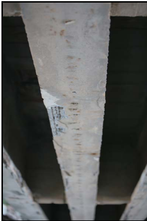
Foto 6.36, Foto 6.37: Manifestazioni di degrado presenti nell'estremità dx e in mezzeria dell'elemento E 13
