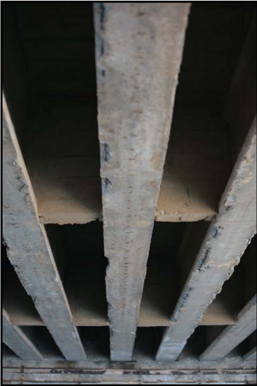
Foto 6.18, Foto 6.19: Manifestazioni di degrado presenti nell'estremità dx, in mezzeria e nell'estremità sx dell'elemento E 6 ,
