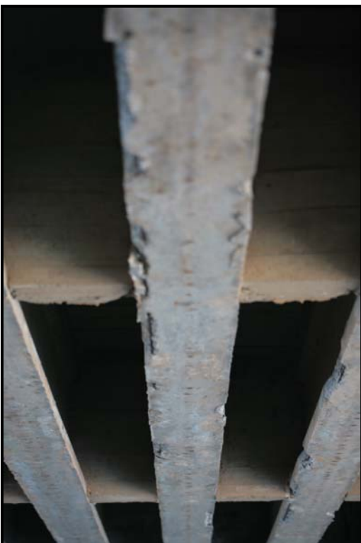
Foto 6.20, Foto 6.21: Manifestazioni di degrado presenti nell'estremità dx, in mezzeria, nell'estremità sx dell'elemento E 7
