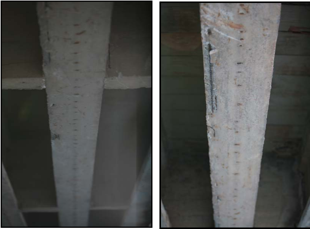
Foto 6.8 e Foto 6.9: Manifestazioni di degrado presenti nell'estremità dx in mezzeria dell'elemento E 2
