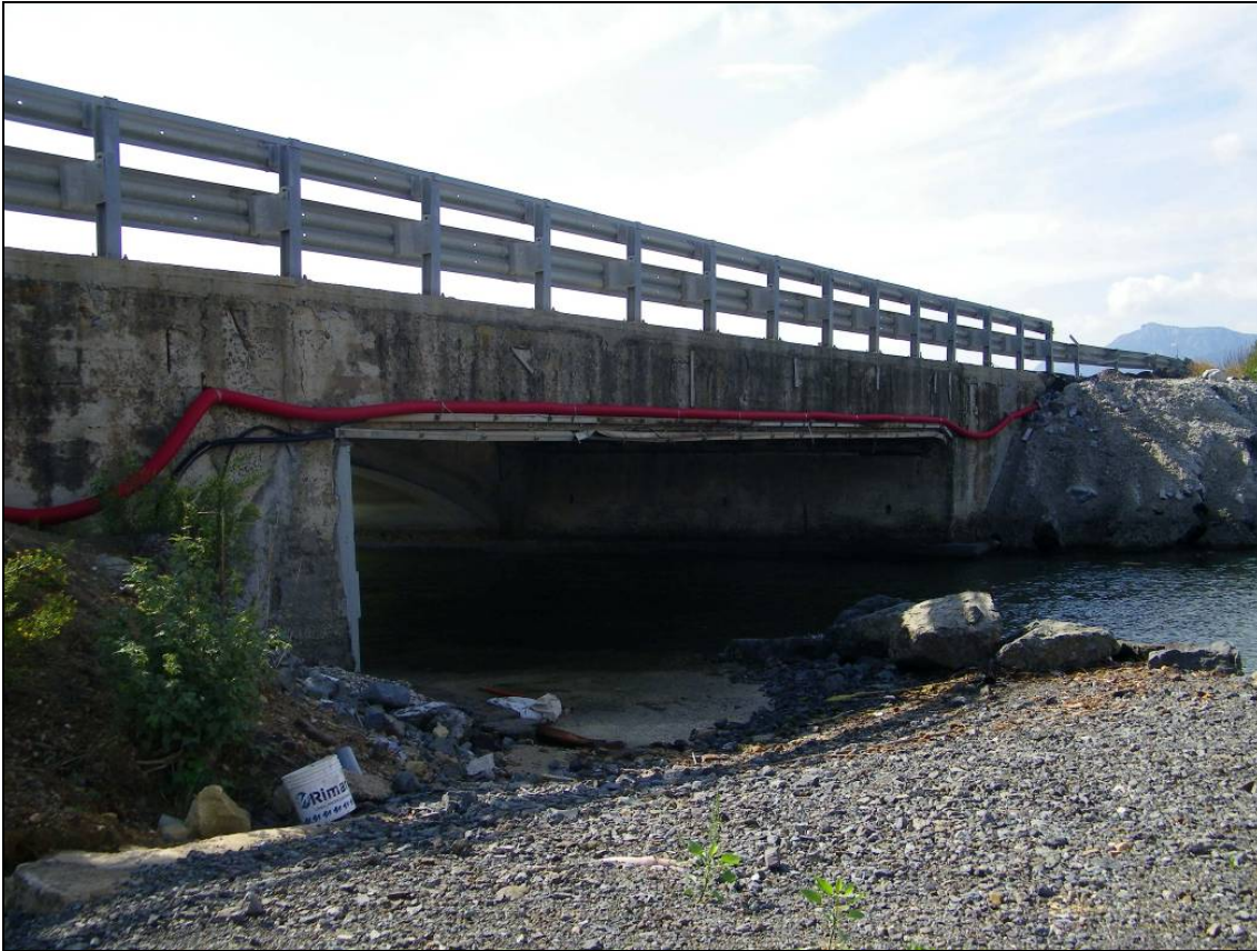
Foto 6.1. Prospetto laterale del ponte
