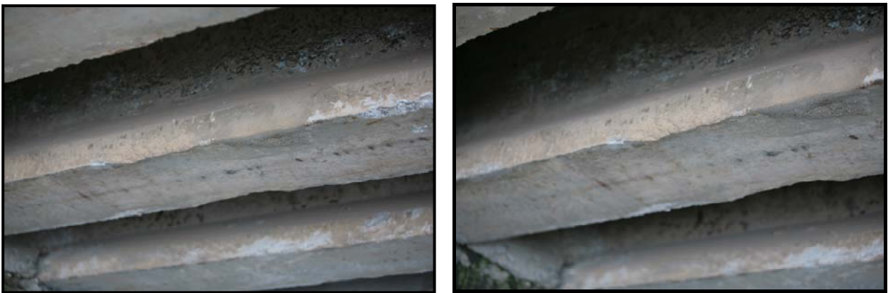
Foto 6.33, Foto 6.34: Manifestazioni di degrado presenti nell'estremità sx dell'elemento E_{11} e dell'elemento E_{12}
