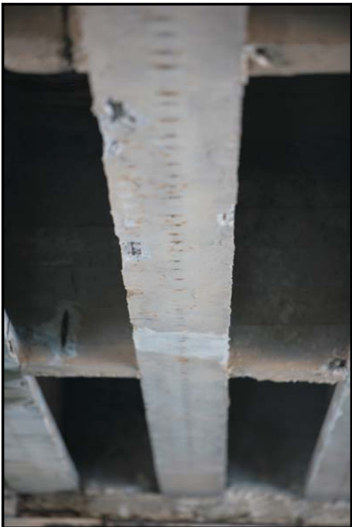
Foto 6.36, Foto 6.37: Manifestazioni di degrado presenti nell'estremità dx e in mezzeria dell'elemento E 13
