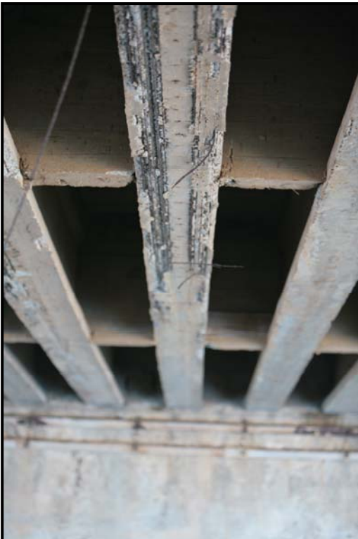
Foto 6.27: Manifestazioni di degrado presenti nell'estremità dx e in mezzeria dell'elemento E 9
