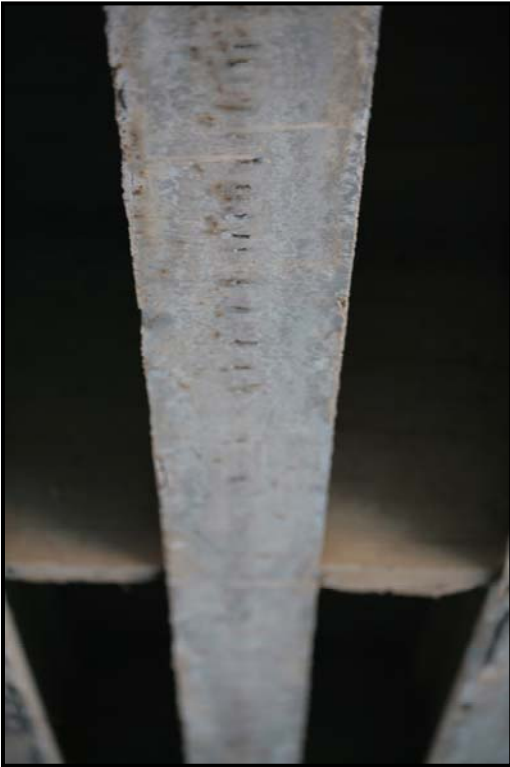
Foto 6.22, Foto 6.23: Manifestazioni di degrado presenti nell'estremità dx, nell'estremità sx dell'elemento E_8
