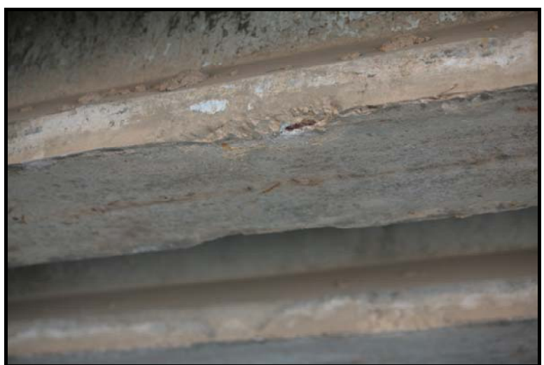
Foto 6.20, Foto 6.21: Manifestazioni di degrado presenti nell'estremità dx, in mezzeria, nell'estremità sx dell'elemento E 7
