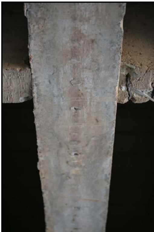
Foto 6.24: Manifestazioni di degrado presenti in mezzeria dell'elemento E_8
