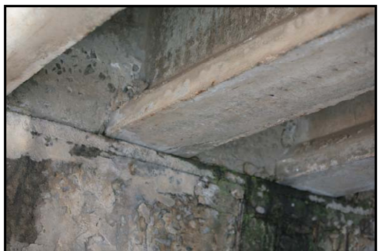
Foto 6.16, Foto 6.17: Manifestazioni di degrado presenti nell'estremità dx, in mezzeria e all'estremità sx dell'elemento E 5
