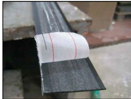
Figura 35. Rimozione della prima pellicola protettiva della lamina.
