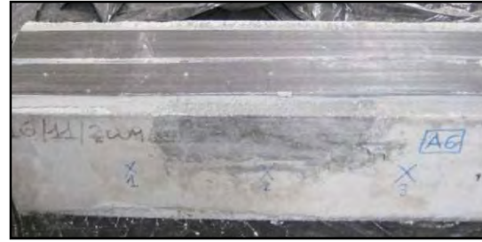
Figura 39. Travetto rinforzato con le lamine in FRP.
