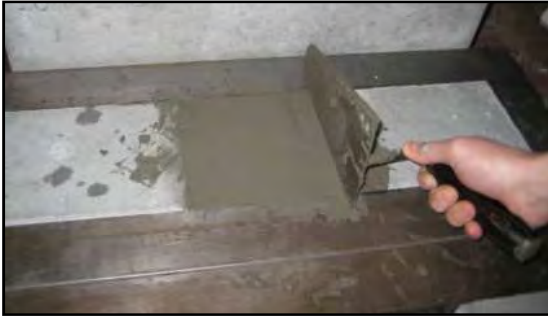
Figura 14. Realizzazione intervento di ripristino.
