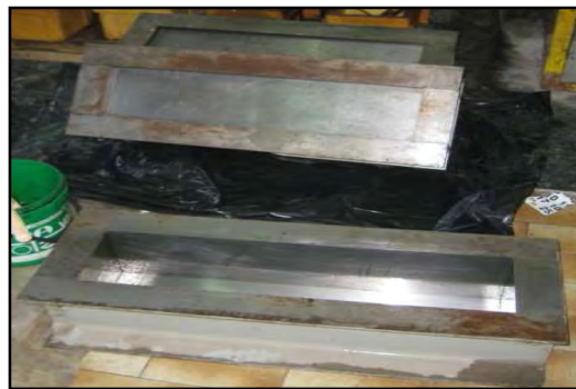
Figura 5. Preparazione dei casseri.
