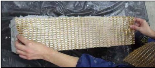
Figura 42. Applicazione rete in PBO.
