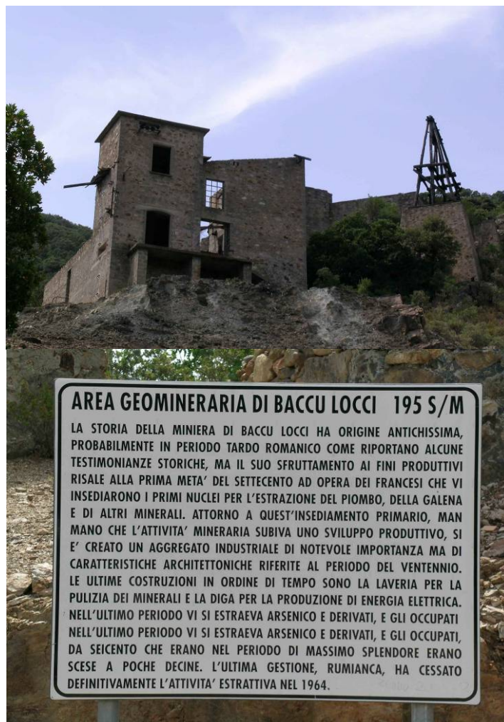
Foto 16 – Parco Geominerario della Sardegna: miniera di Baccu Locci (Villaputzu).
