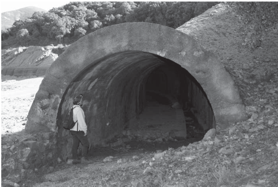
Figura 2. Imboccatura di un tunnel in calcestruzzo.
