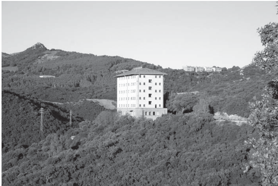
Figura 3. L'edificio dell'ex Albergo Sartori costituisce un tipico rifugio per i pipistrelli.
