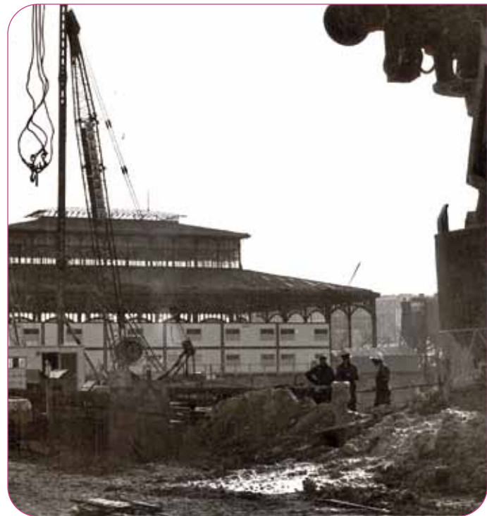
Marché des Halles : Démolition des pavillons signés Victor Baltard (1973) © Jacques Deneux
