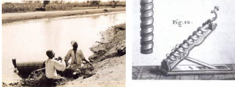
Figure 1.2 : 1 ère utilisation d'une surface hélicoïdale, la vis d'Archimède.
