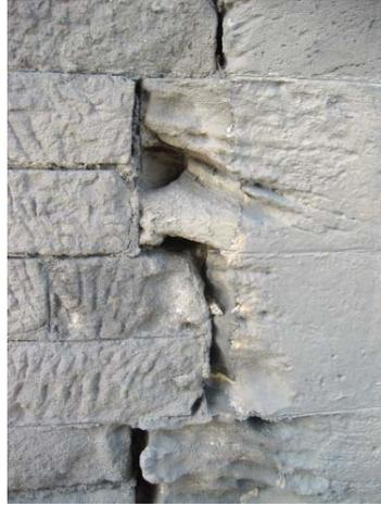
Figure 36 - Décollement entre le chaînage en pierre de taille et les moellons. Photos N. D.
