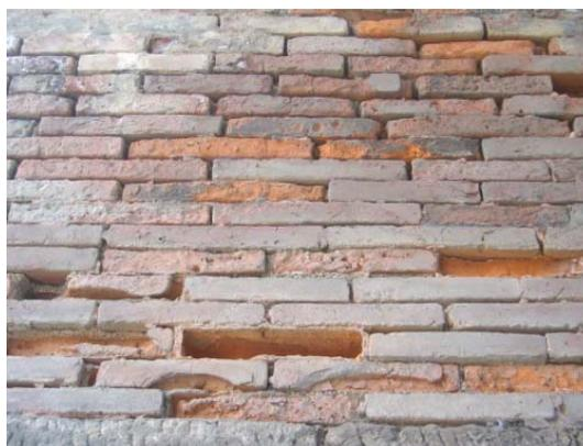
Figure 35 - Altération des briques, des pierres de taille et des moellons. Photos N.D.
