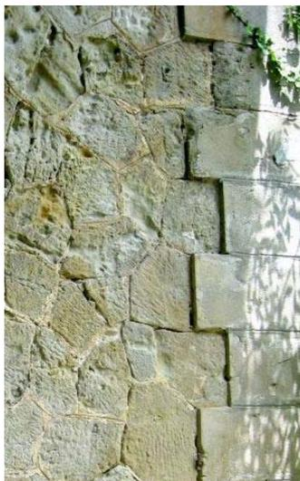
*Figure 34 - Pont de Leingary : détail des maçonnerie de moellons en opus incertum, et pierre de taille. Photo N. D.*
