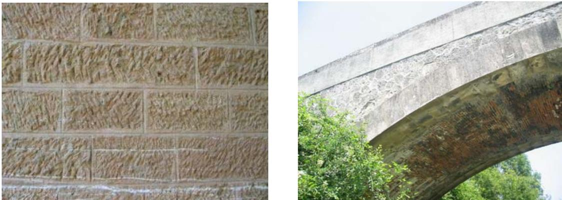
Figure 31 - A droite : PS de la Millette, murs en maçonnerie de moellons à joints incertains (opus incertum), bandeau en pierre de taille, corps de voûte en briques. A gauche : Pont de Montsalvy, détail de maçonnerie à moellons smillés à assise horizontale.
