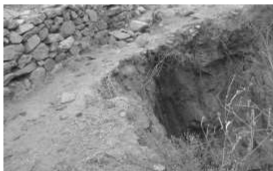
Foto N° 3 Se observa la cárcava CIIb cerca de la pirca que rodea la Plaza
