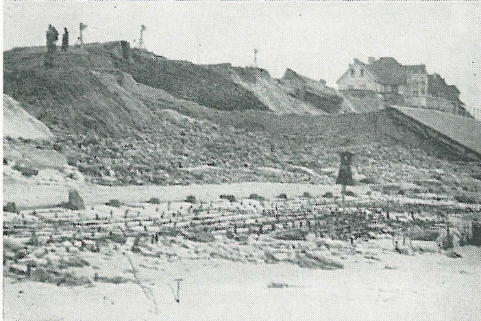
Près du Lebberbek le 1 février 1953 : la force des vagues a rompu la digue.
